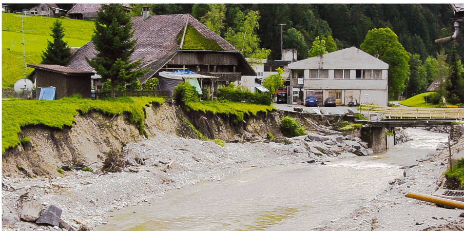
Bild 1. Ufererosion an der Trueb beim Hochwasser 2005. Foto: Flussbau AG SAH.
