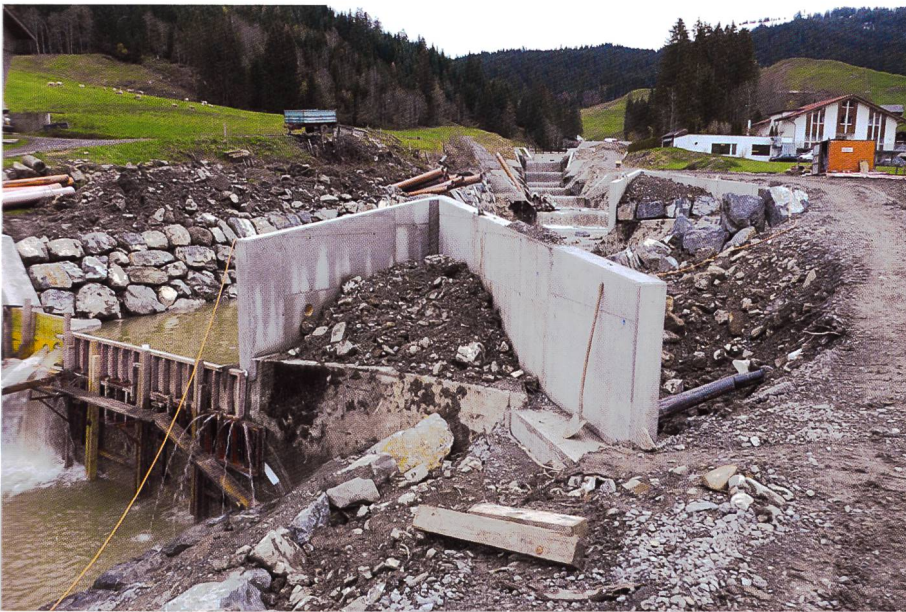
Bild 11. Bau der Ausleitstrecke im Herbst 2014, Sporn Nr. 28 von unterstrom her gesehen.
