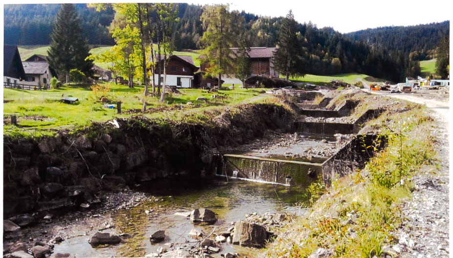
Bild 1. Ausleitstrecke mit klassischen Betonsperren vor dem Umbau.
