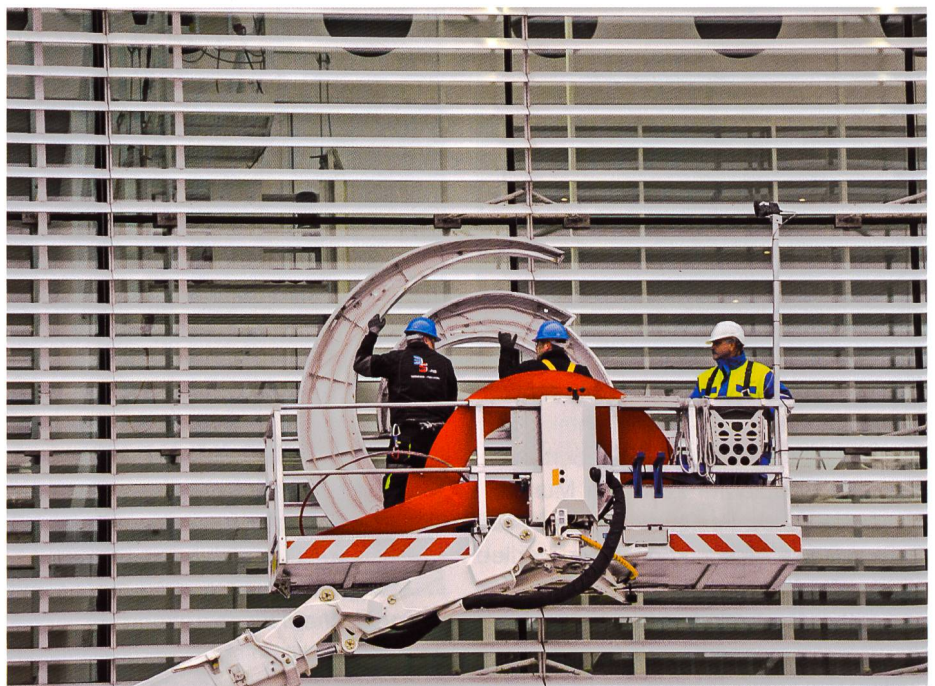
Aufnahmen vom Rebranding des Alstom-Gebäude in Baden.
