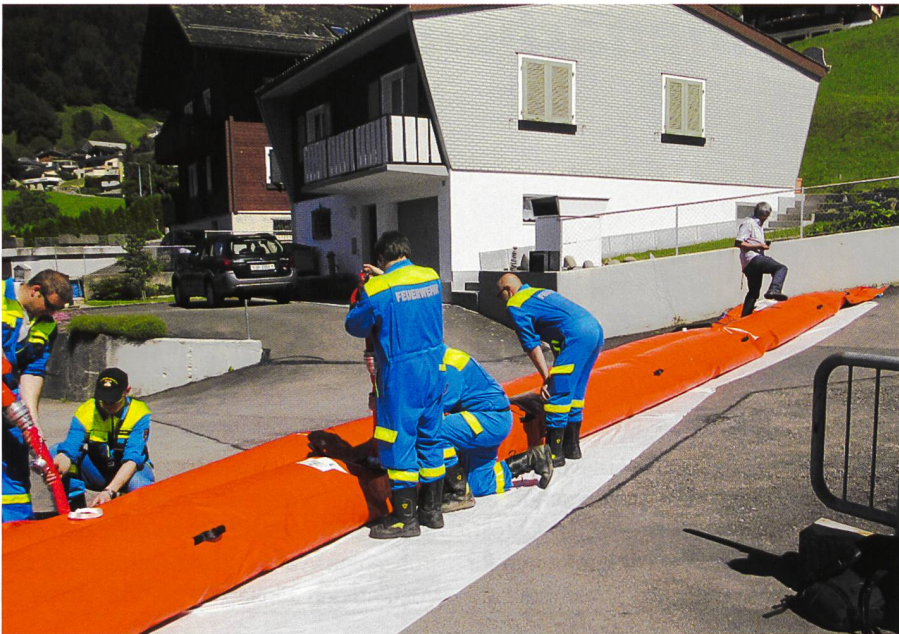
Bild 3. Einbau Beaver-Schläuche.
