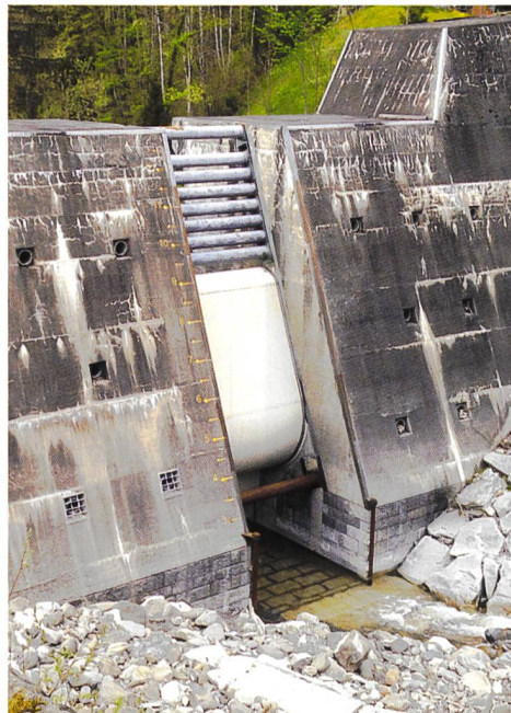
Bild 2. Schütz-Geschiebesammler Stiglisbrücke.
