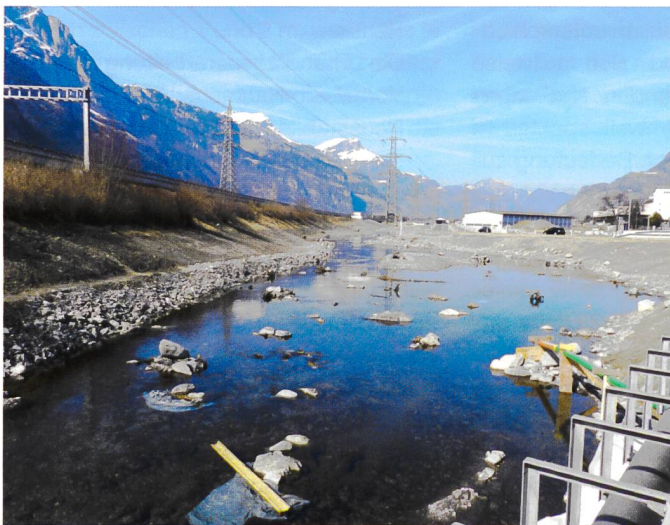
Bild 1. Neuanlage und Verlängerung Gerinne und Gewässerraum der Stillen Reuss (Foto Sigmaphan).
