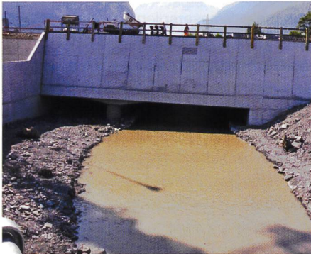
Bild 3. Ansicht neuer Durchlass Stille Reuss unter dem Schächen hindurch.
