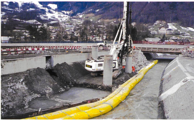
Bild 1. Erstellen der Bohrpfähle im Schächen.
