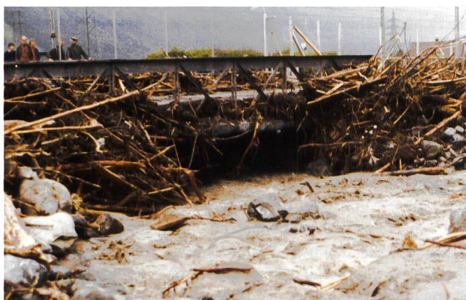
Bild 2. Verklausungen an der Schächenbrücke bei der RUAG im Juli 1977.
