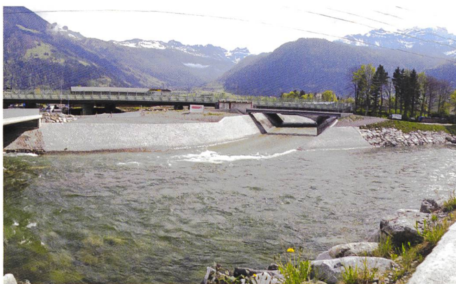
Bild 7. Bereich Schächenmündung, Anschluss Schächen an die Reuss.
