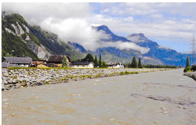
Bild 9. Erhöhter Reussdamm bei Attinghausen.
