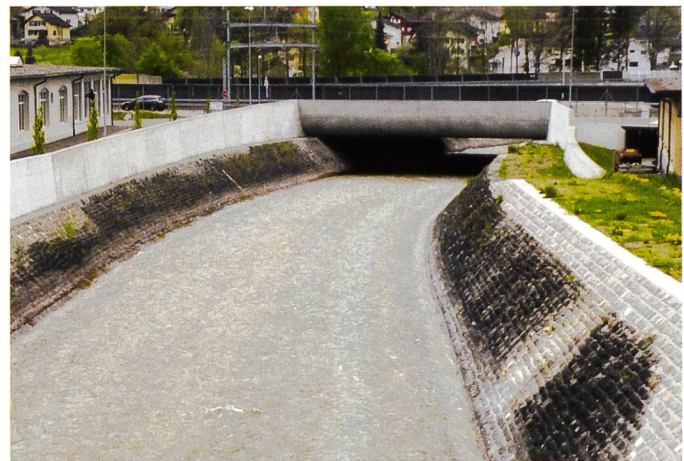
Bild 6. Druckbrücke mit Kragenmauern.
