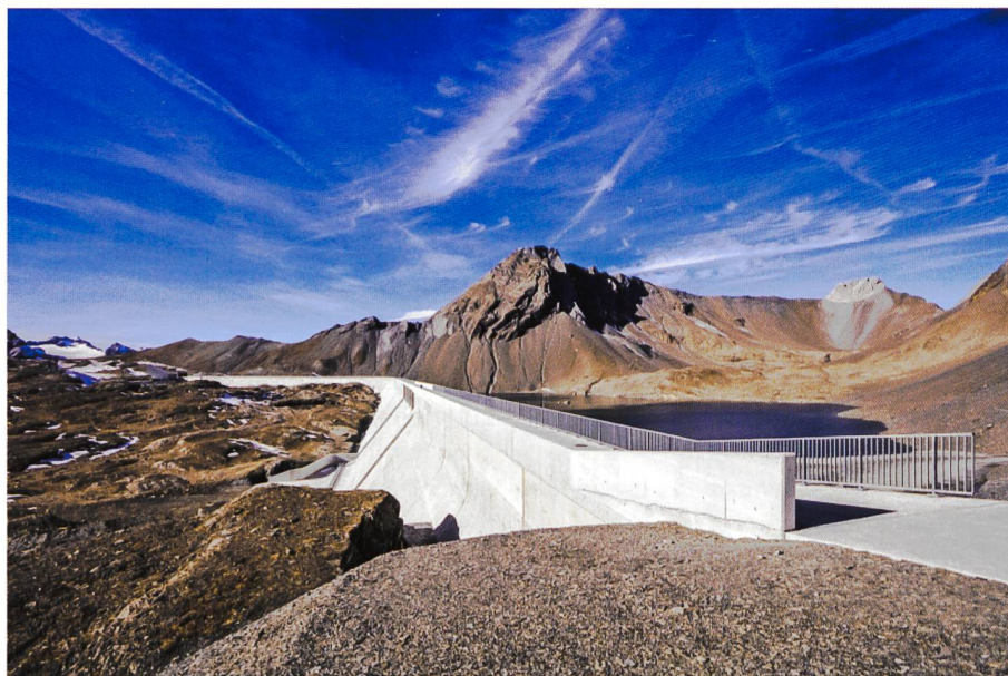
Bild. Staumauer Mutsee im Nov. 2015 (Quelle: Axpo).
