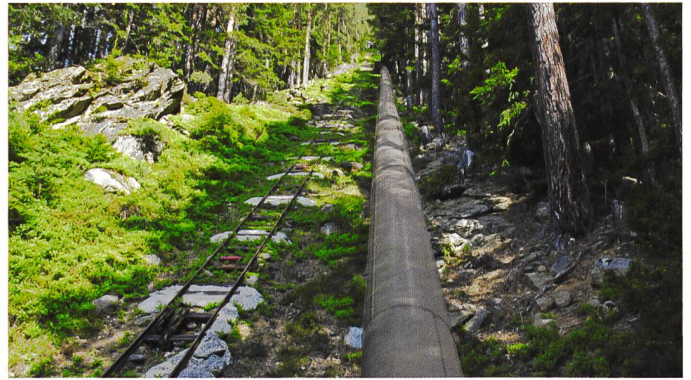
Bild 3. Die neue Druckleitung wird am gleichen Ort verlegt, jedoch teilweise unterirdisch geführt.
