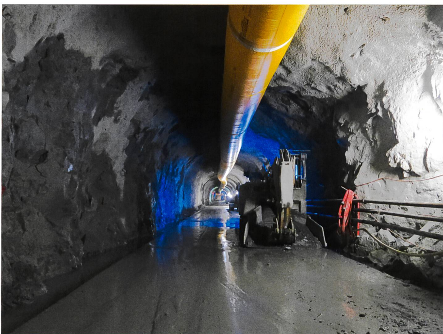
Bild 6. Massgeschneiderte Auskleidung im Unterwasserstollen des Kraftwerks Innert- kirchen 1 und 1E.
