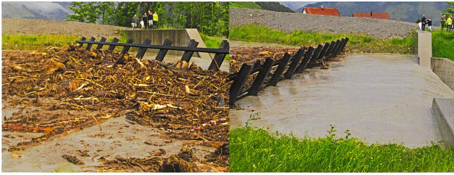
Bild 4. Holzablagerungen im Rechen (Fotos: R. Holdener).
