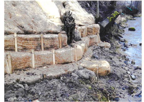
Bild 5. Howolis-Q-Faschine: Die flexiblen Holzwolle-Faschinen erlauben die Verlegung entlang der individuellen Uferlinie. Ebenso lassen sich Rauigkeitselemente wie Kleinbuhnen und Sporne modellieren.
