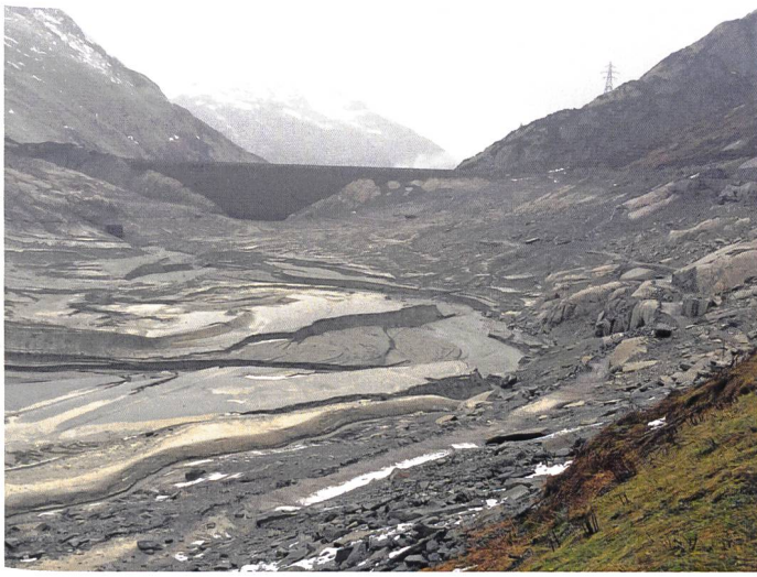
Bild 5. Foto vom leeren Stausee mit Erosionsrinnen (Bild: Stefan Schweizer).
