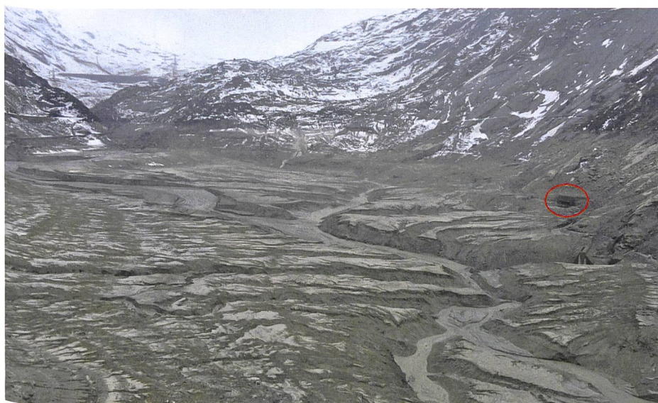
Bild 8a (ganz oben) und 8b. Vergleich des entleerten Räterichsbodensees, oben Situation von 1974 (Bild 8a) und unten Situation von 2014 (Bild 8b). Anhand des eingekreisten Bauwerks (Vorsortierwerk für den Bau der Staumauer) lässt sich die Verfüllung mit Sediment gut erkennen.
