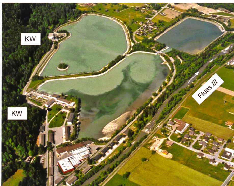
Bild 4. Ausgleichsbecken Rodund in Österreich (Vorarlberg) mit Eintrag von Gletscherschliff durch die Oberliegerkraftwerke und von teils größeren Sedimenten durch die Wasserfassung an der III (Sollerer und Matt 2013).
