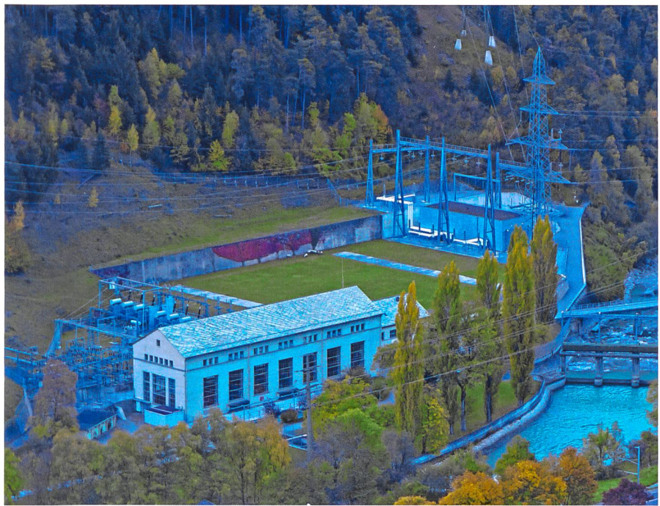
Bild 4. Wasserkraftanlage Mörel der Rhonewerke.
