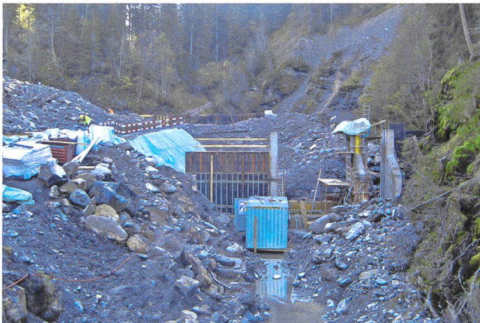
Bild 12. Blick auf das Wehr der Fassung Albristbach gegen Fliessrichtung (Okt. 2014).
