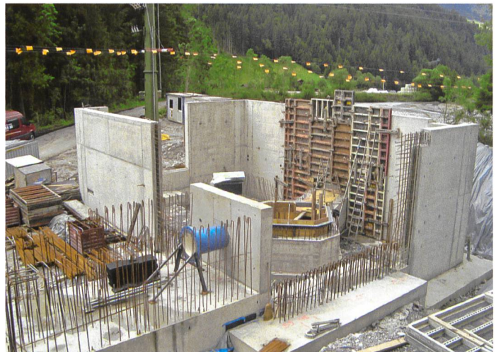
Bild 15. Blick auf die Zentrale Matten, links zukünftiger Fixpunkt (Bewehrung) und in der Mitte Turbinenstandort (Juni 2015).
