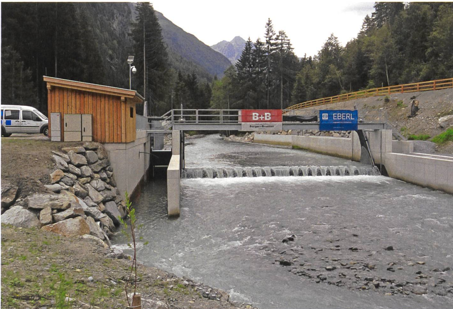
Bild 3. Der zur Zeit grösste Coanda-Rechen Europas bei St. Leonhard am Pitzbach Tirol, mit einer Schluckfähigkeit von 4000 l/s. Der Coanda-Rechen befindet sich unterirdisch links neben der Klappenschütz (auf dem Foto nicht sichtbar). Sichtbar ist nur der Spülkanal nach dem Coanda-Rechen. Der Betonkanal auf der rechten Seite ist der Fischpass.
