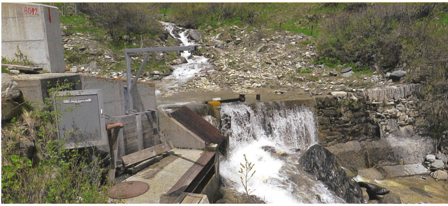
Bild 2. Der erste Coanda-Rechen der Schweiz kam 1998 am Rappierbach in der Gemeinde Hinterrhein (GR) zum Einsatz. Der Stababstand des einen Meter breiten Rechens beträgt 1 mm, die Schluckfähigkeit 140 l/s. Auf dem Bild liegt der Coanda-Rechen unterhalb des Schutzrostes versteckt. Der Rost dient dazu, bei Hochwasser grosse Steine vom Coanda-Rechen fernzuhalten.
