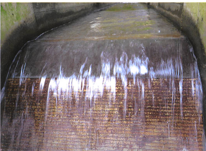
Bild 4. Nahaufnahme eines Coanda-Rechens: Die horizontalen Metallstäbe wirken wie Rasierklingen, die das Wasser schichtenweise abscheren.
