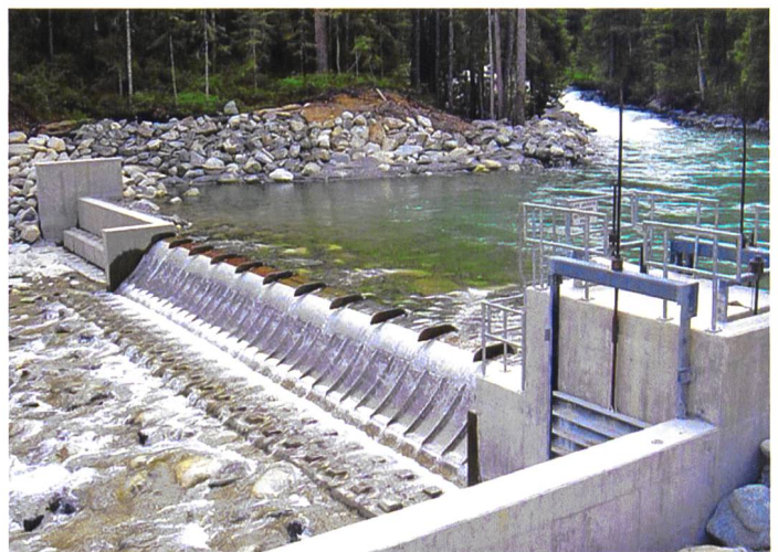
Bild 5. Grosse Wasserfassung mit einem Coanda-Rechen in Kanada (Schluckfähigkeit: 4000 l/s).
