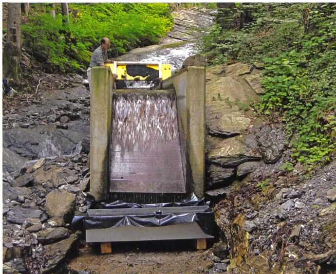
Bild 9. Bauingenieur Franco Schlegel, Dozent am Institut für Bauen im alpinen Raum (IBAR) der HTW Chur, bei der Eingabe einer vorgefertigten Geschiebemischung in den Mühlbach (Oberschan/SG) vor dem Coanda-Rechen. In der Wanne unterhalb des Coanda-Rechens werden die Teile der Mischung aufgefangen, die nicht durch den Rechen gedrungen sind.
