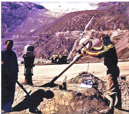
Reimer Bonhage (rechts) als junger Ingenieur bei Setzungsmessungen auf der Baustelle des Staudammes Mattmark (Quelle: zvg).
