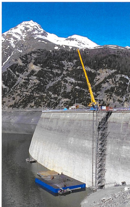
Installation Ponton für Unterwasserarbeiten Punt dal Gall (Bild: EKW)
