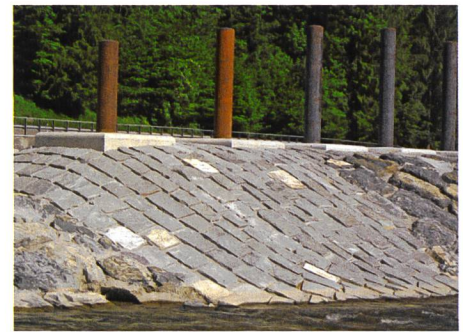
Bild 15. Umgesetzte Vorgabe am Bau: Die Übergänge zum Uferblocksatz aus formwilden Alpenkalksteinen bestehen aus gerichteten Quarzsandsteinen.
