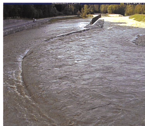
Bild 18. (Videoaufnahme, Blick in Fließrichtung): Hochwasser am 3. September 2017 (rund 100 m 3 /s, ca. HQ 1 ). Die Wehrschwelle wurde, wie aus den Modellversuchen zu erwarten war, leicht überströmt und es wurde wenig Holz in den Rückhalt eingetragen.
