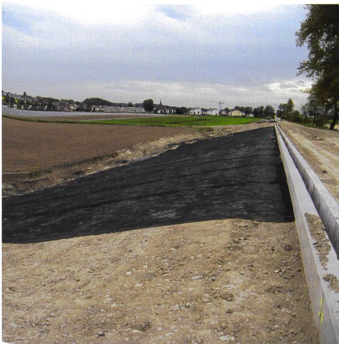
Bild 6. Hochwasserrückhaltebecken Wohlen, Damm mit luftseitigem Erosionsschutz (Silvio Moser).
