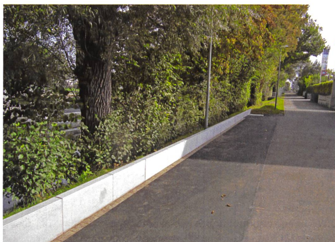
Bild 9. Teilausbau Bünz Wohlen, Ufererhöhung mit Winkelplatten und Erddamm (Seippel Landschaftsarchitekten GmbH).
