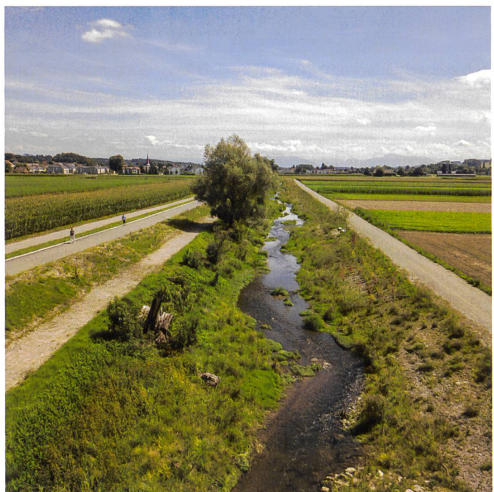
Bild 7. Hochwasserrückhaltebecken Wohlen, Seitendamm und revitalisierte Bünz mit Blick gegen Fließrichtung (Jonin Zumsteg).
