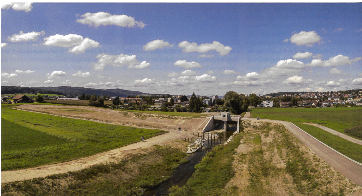
Bild 5. Hochwasserrückhaltebecken Wohlen, Querdamm und Durchlassbauwerk (Jonin Zumsteg).
