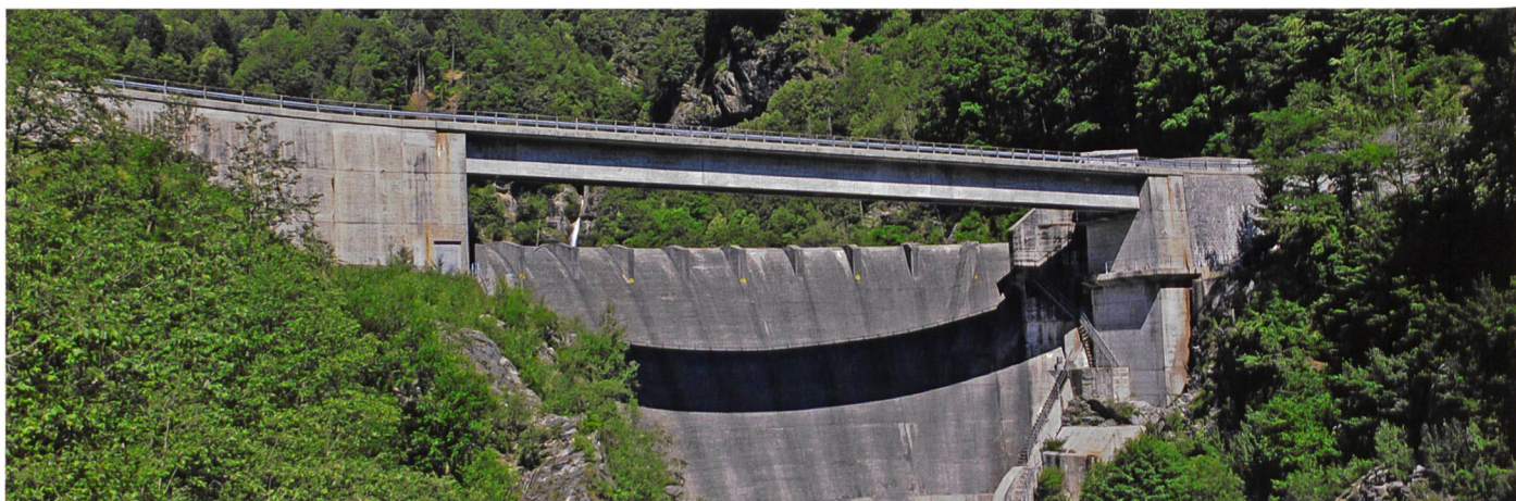
Bild 2. Neues HWE-Einlaufbauwerk ohne Wehrbrücke der Stauanlage Palagnedra, Kanton Tessin (Foto: Ofima).
