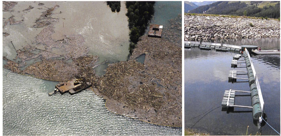
Bild 7. Links: Schwemmholzsperrern auf dem Brienersee, Kanton Bern, beim Hochwasserereignis 2005 (Foto: Bundesamt für Umwelt, Ittigen). Rechts: Schwimmrechen (Foto: H. Czerny, Bundesministerium für Land- und Forstwirtschaft, Umwelt und Wasserwirtschaft, A).
