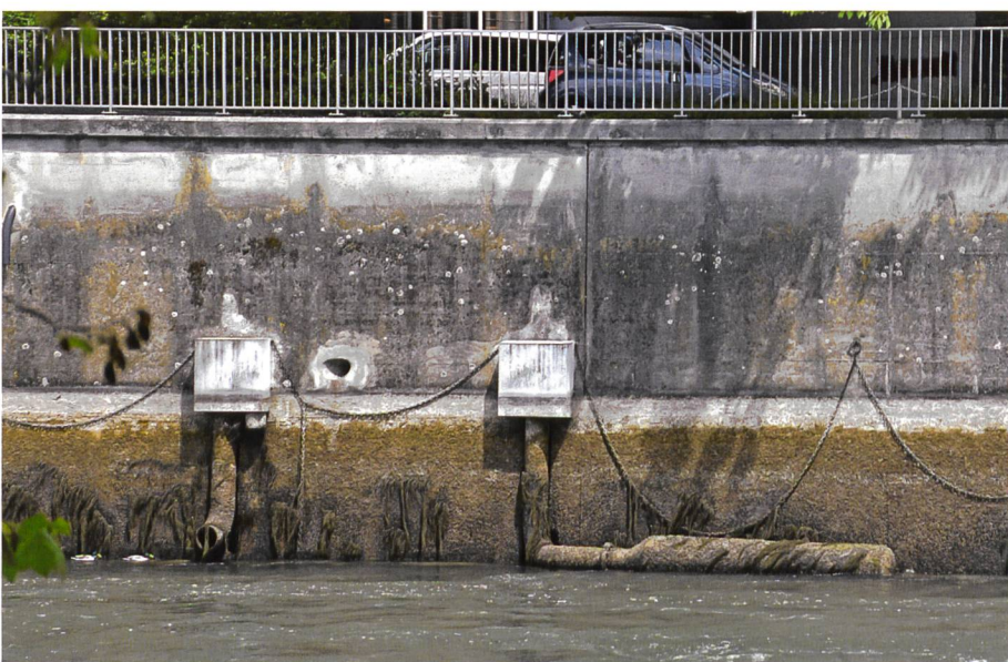
Bild 3. Freigelegte Kühlwasserentnahme oberhalb des Platzspitzwehrs, Fliessrichtung von rechts nach links. Rechts die Fassung mit dem Seiher, links die Rückgabe (Quelle AWEL).
