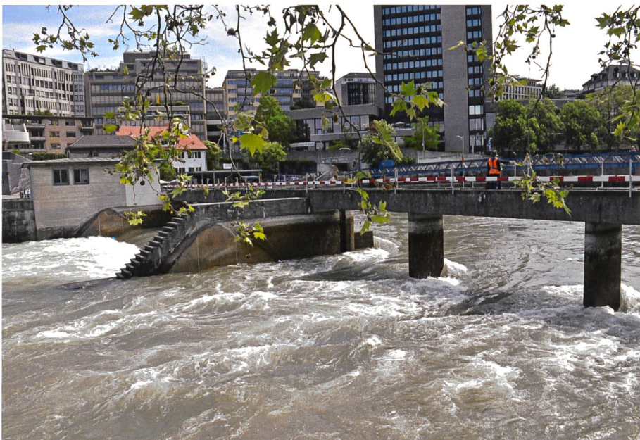
Bild 2. Das abgelegte und für zwei Stunden beinahe frei durchströmte Platzspitzwehr, 230 m 3 /s (Quelle AWEL).
