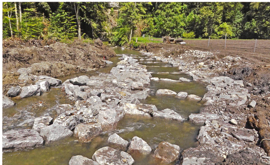
Bild 3. Im Bau: Das Niederwassergerinne in Beckenform ist gut sichtbar. Die angestrebte Wasserspiegeldifferenz von 14 cm pro Becken konnte durch den Bau ohne Wasserhaltung und entgegen der Fliessrichtung gut eingestellt werden.
