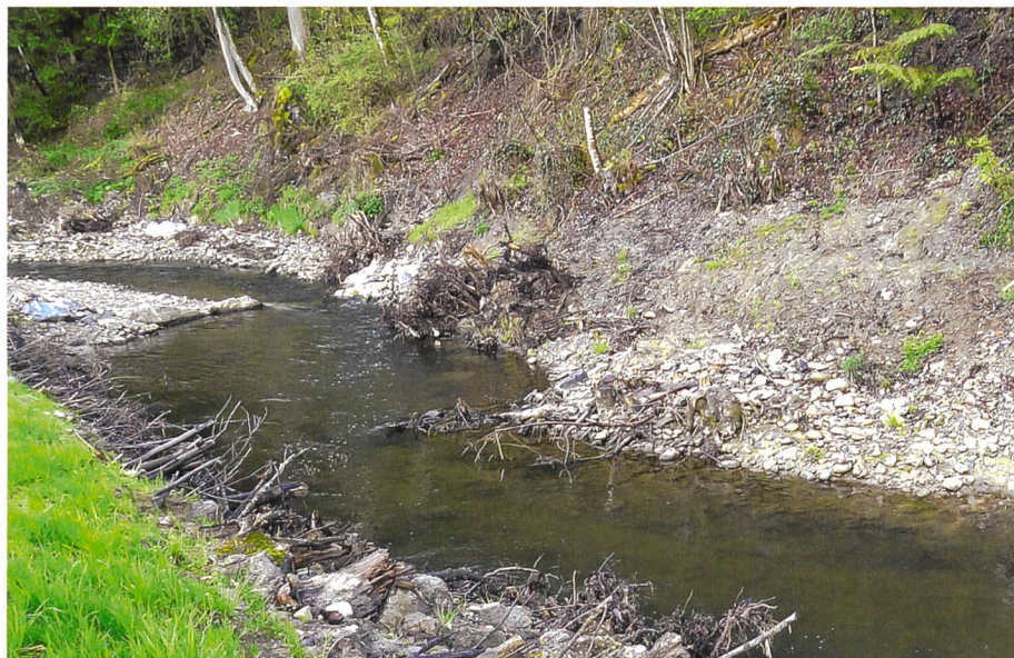
Bild 8. Der revitalisierte Bereich oberhalb des ehemaligen Wehrs weist nun natürliche Fließgeschwindigkeiten auf und ein Niederwassergerinne mit Totholzstrukturen.
