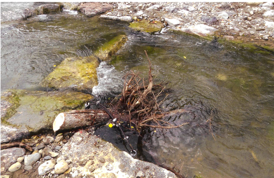
Bild 4. Die Wurzelstöcke werden als Unterstand nachträglich im Niederwassergerinne befestigt.
