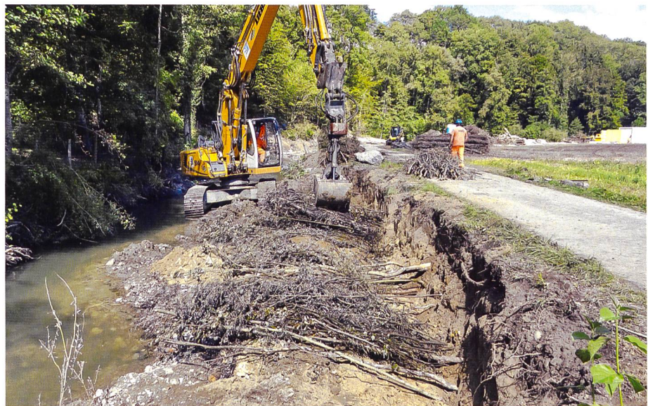
Bild 5. Die Ufer werden mit Faschinen und Buschlagen gesichert.
