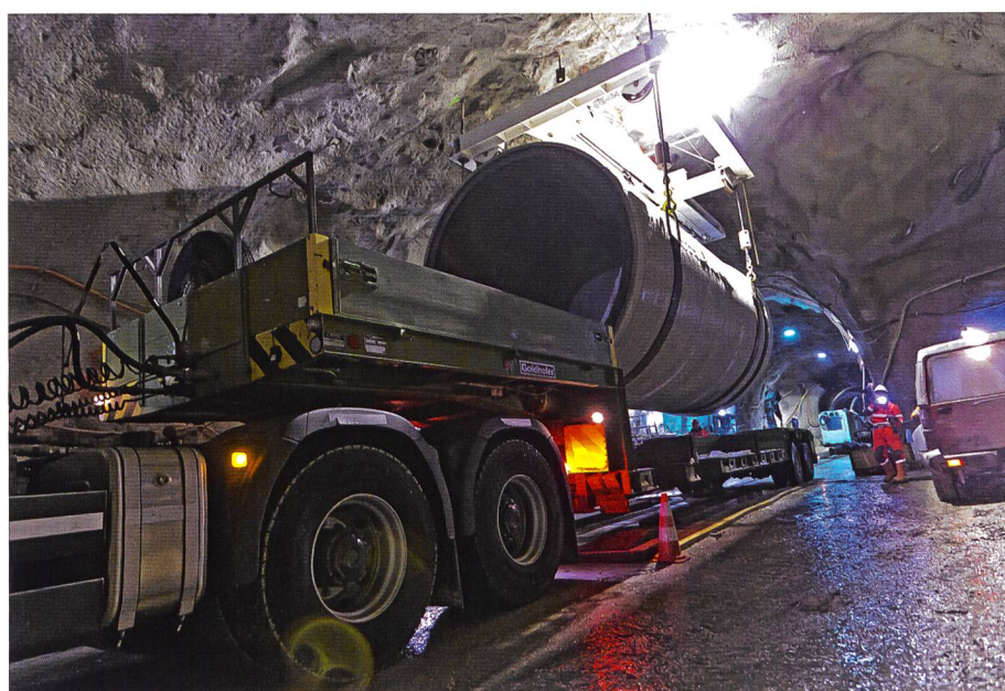
Bild 5. Montage der GFK-Rohre.
