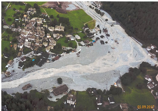
Bild 4. Ablagerungen im Bereich des Auffangbeckens in Bondo nach den Murgängen vom August 2017.
