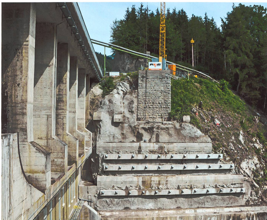
Figure 17. Vue de l'éperon une fois les travaux terminés.
