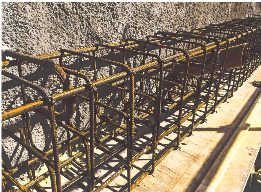
Figure 5. Armatures des longrines avec tuyau de réserve pour les ancrages.
