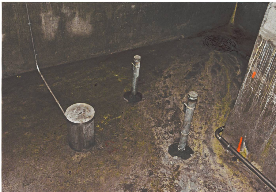
Figure 16. Drains et piézomètres dans le barrage.
