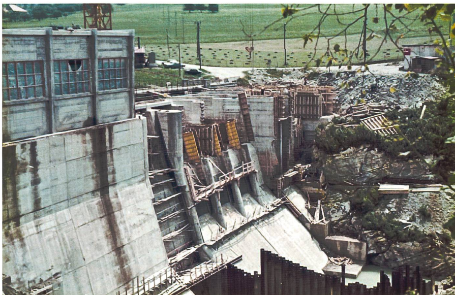
Figure 1. Photo de la construction du barrage.
