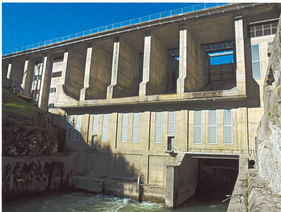
Figure 3. Vue aval du barrage.
