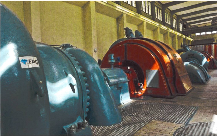
Die Maschinen der Zentrale Mottec werden in den Jahren 2020–2022 erneuert (Bild: Alpiq).
