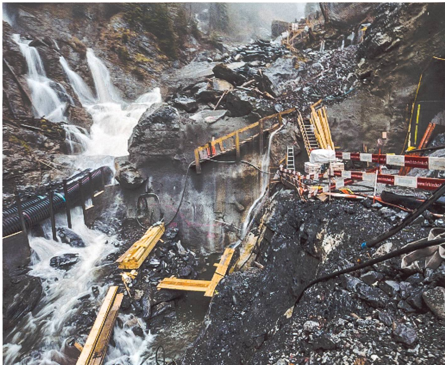
Bau des Fassungsbauwerks am Berschnerbach (Bild: WEW).
