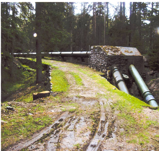
Druckleitung Balbalera, Fixpunkt 5, Übergang von Flach- auf Steilstrecke.
