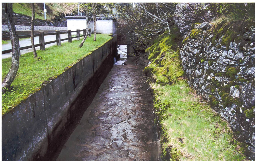
WF Puntalta, Kanal bzw. Sandfang, im Hintergrund Apparategebäude.
