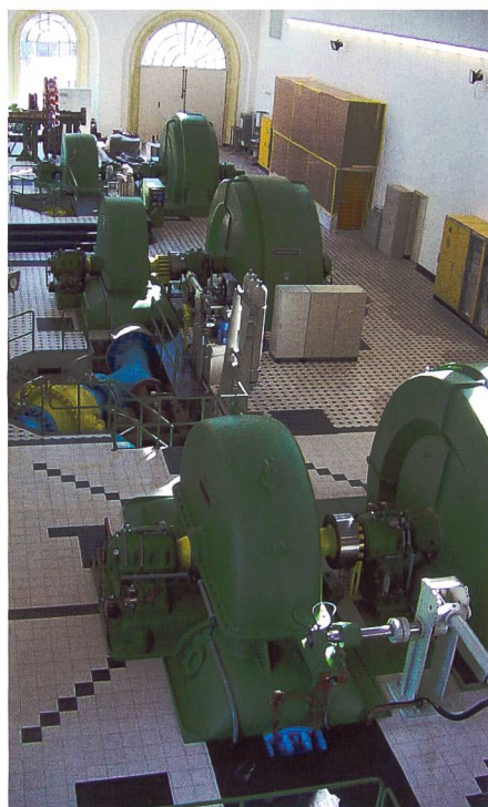
Bestehender Maschinensaal KW Robbia.
