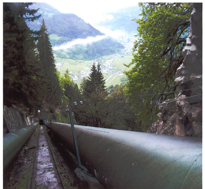
Druckleitung Balbalera, Steilstrecke, Blick Richtung Rohrstollen 2.
