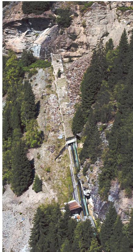
DL Balbalera, bestehende Steinschutzgalerie über den Druckleitungen.
