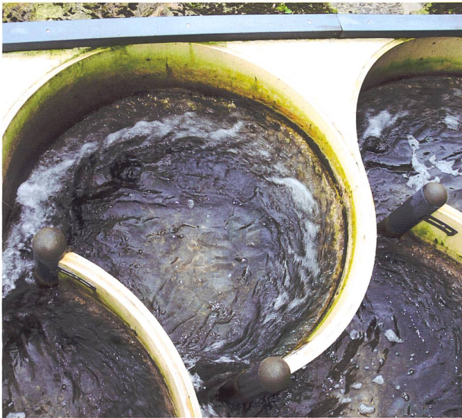
Bild 8: Links: Strömungsmuster in einem RBP Typ C (Beispiel: Birs / Courendlin JU; Foto: J. Stork), rechts: Strömungsmuster («strömungsdissipierend» – linker Strang und «strömungsstabil» – rechter Strang, nach DWA, 2014) in einem konventionellen Schlitzpass (Beispiel: Mosel / Koblenz, Rheinland-Pfalz; Foto: M. Mende).
