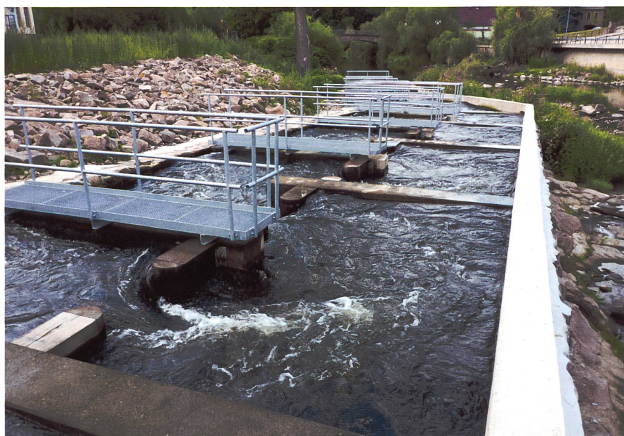
Bild 6: Konventioneller Schlitzpass mit alternierender Beckenführung (Foto: www.ib-handrick.de).
