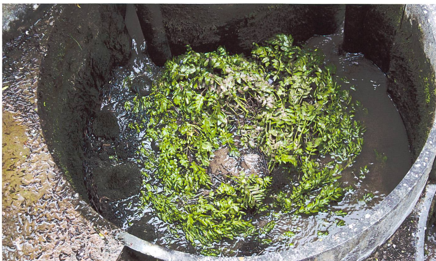
Bild 4: Trocken gelegter Typ C mit Wassersellerie im Beckenzentrum (Foto: U. Helbig).
