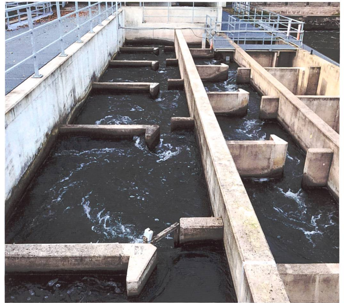
Bild 8: Links: Strömungsmuster in einem RBP Typ C (Beispiel: Birs / Courendlin JU; Foto: J. Stork), rechts: Strömungsmuster («strömungsdissipierend» – linker Strang und «strömungsstabil» – rechter Strang, nach DWA, 2014) in einem konventionellen Schlitzpass (Beispiel: Mosel / Koblenz, Rheinland-Pfalz; Foto: M. Mende).
