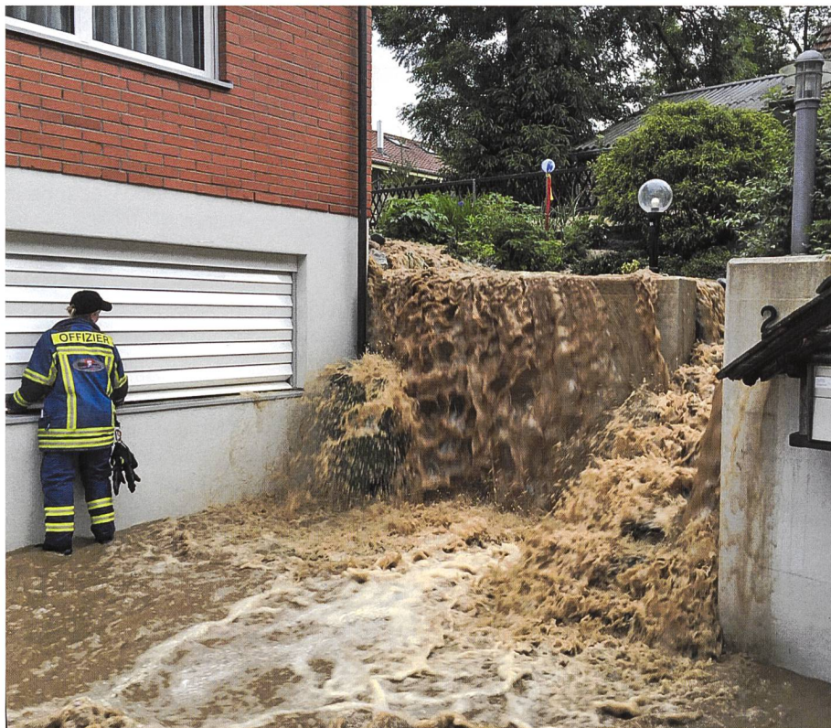
Die Verletzlichkeit von Gebäuden – im Bild die Folgen von Oberflächenabfluss in Othmarsingen AG 2016 – hängt stark von den Baueigenschaften ab.
