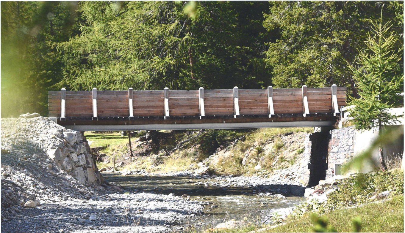
Die neu gebaute, höher gelegene Brücke vermeidet Abbaggerungen und die damit verbundene Zerstörung der Uferhabitate.
