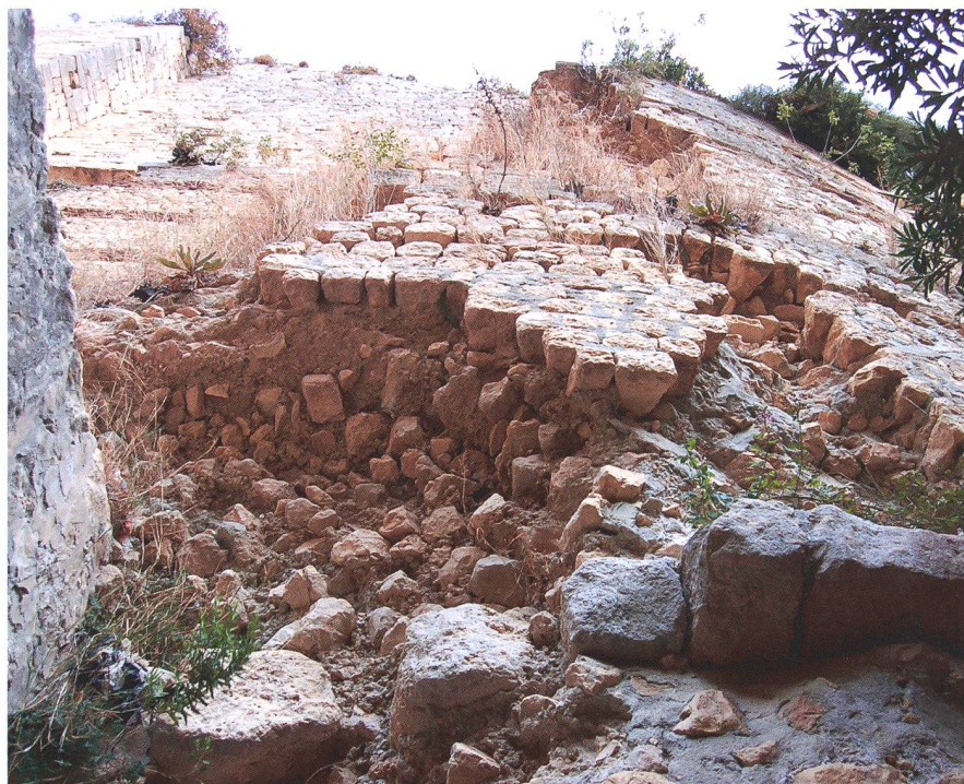
Bild 7: Beschädigte zylindrische Stauwand.
