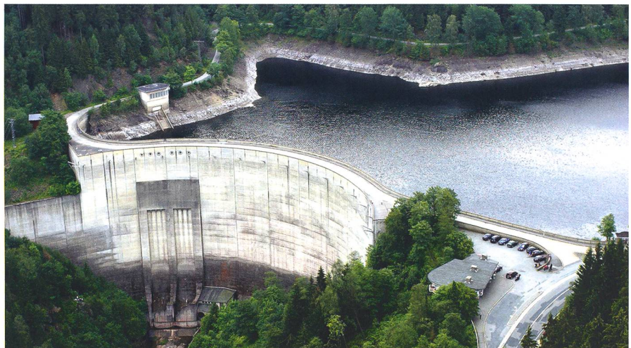
Bild 9: Die 75 m hohe Okertalsperre/Harz (Foto: Harzwasserwerke).
