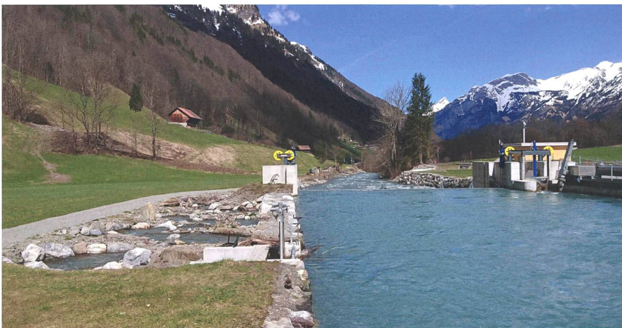
Kraftwerk Rufi, auf der linken Seite der Fischeausstieg des Umgehungsgewässers. Rechts die Fassung in den 3-Kammer-Entsander.
