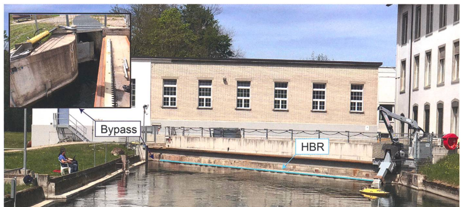
Bild 1: Das Laufwasserkraftwerke Stoppel in der Gemeinde Untersiggenthal (AG) ist mit einem horizontalen Fischleitrechen (HBR) ausgerüstet, der die in der Limmat lebenden Fische (u. a. Schneider, Barben und Rotaugen) in einen Bypass leitet, damit sie am Kraftwerk vorbei flussabwärts wandern können. Bei grösseren Laufwasserkraftwerken werden Fischleitrechen bisher in Europa nicht eingesetzt (Foto: Ismail Albayrak, VAW).
