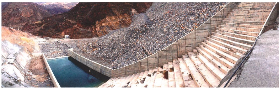
Bild 1: (a) Pedrógão-Staudamm mit Treppenschussrinne, Portugal (I. Stojnic), und (b) Treppenschussrinne mit Tosbecken an der Flanke des Steinschüttdamms des Pumpspeicherwerks Siah Bishe im Iran (M. Katterbach).
