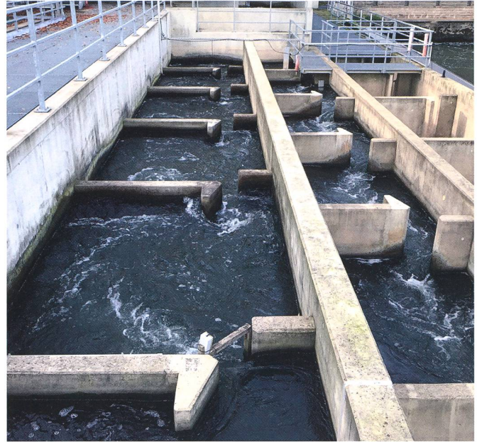
Figure 8: A gauche: schéma d'écoulement dans une passe à méandres de type C (exemple: Birse/Courendlin JU; photo: J. Stork); à droite: schéma d'écoulement («dissipation d'énergie» – côté gauche et «écoulement stable» – côté droite, selon DWA 2014) dans une passe à fentes verticales (exemple: Moselle/Coblence, Rhénanie-Palatinat; photo: M. Mende).
