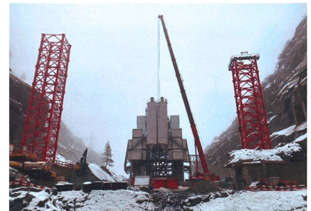
Baustelle Staumauer Spitallamm (Bild: SWV).
