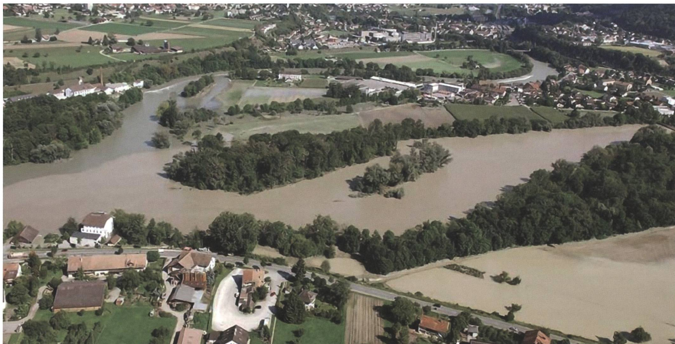
Aare beim Wasserschloss in Brugg (AG) während dem Hochwasser 2005. Foto: Schweizer Luftwaffe.
