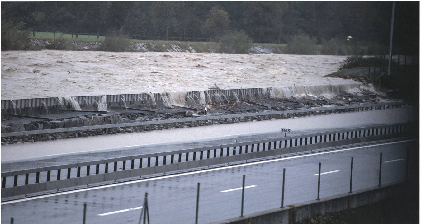
Bild 8: Die hochgehende Reuss wurde am 3. Oktober über die Entlastungsanlage bei Altdorf auf die Autobahn A2 abgeleitet. (Foto: Valentin Luthiger).
