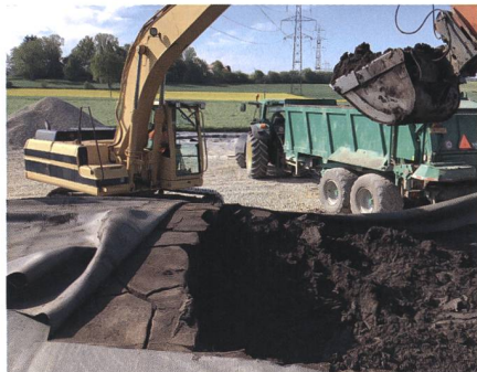
Bild 8: Das entwässerte Sediment wird direkt aus den Geotubes für die landwirtschaftliche Verwertung aufgeladen.
