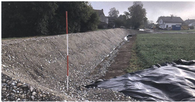
Bild 4: Entwässerungsgraben und Randdamm des Entwässerungsplatzes vor Einbringen der Abdichtung.
