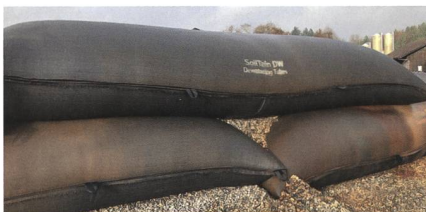
Bild 6: Übereinandergeschichtete volle Entwässerungsschläuche (Geotubes) mit rötlichen Eisenoxid-Ausfällungen durch die Entwässerung.
