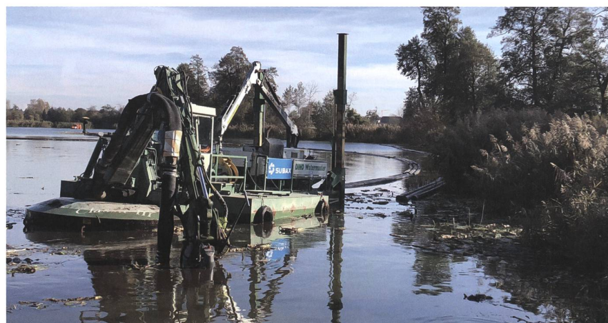
Bild 2: Der schwimmende Saugbagger entfernt die oberste Schicht des Sediments durch den am Hebelarm befestigten Saugkopf (nicht erkennbar im Wasser). Rechts hinter dem Saugbagger ist die Leitung erkennbar, durch welche das Sediment zum Entwässerungsplatz gepumpt wird.
