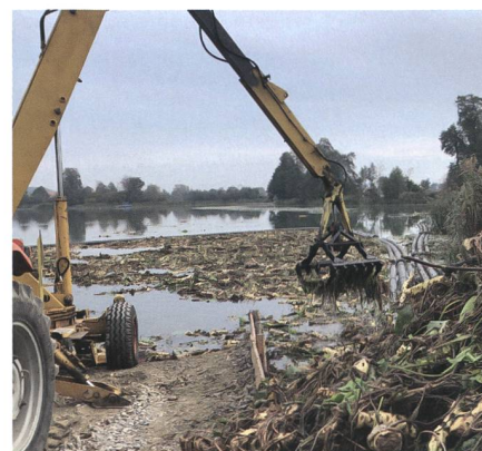
Bild 3: Die gemähten Teichrosen und abgereichten Rhizome werden bei der Einwasserungsstelle aus dem See entfernt und direkt daneben gelagert.
