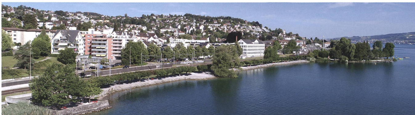
Bild 17: Heutiger Zustand des Seeuferabschnitts «Garnhänki» in Richterswil.
