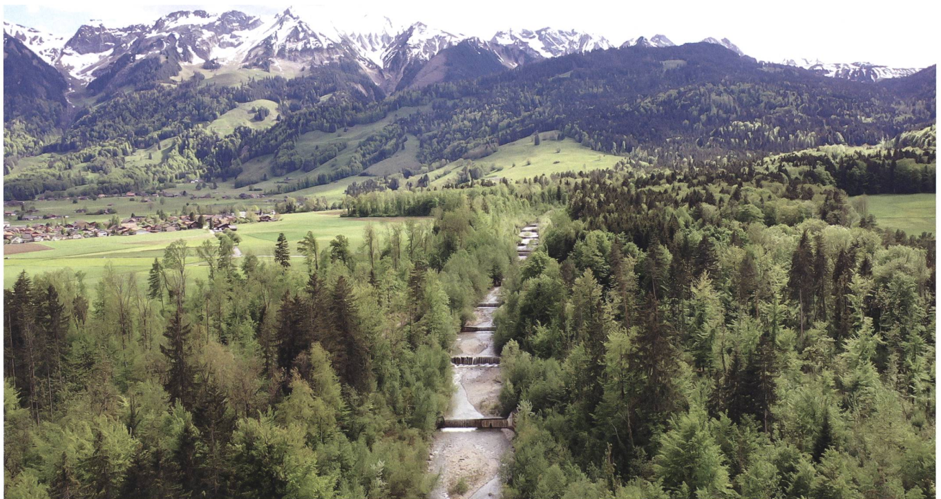
Sperrentreppe in der Gürbe im Gebiet oberstrom der Ausschütte bis Blumensteinbrücke. Foto: Jürg Speerli.
