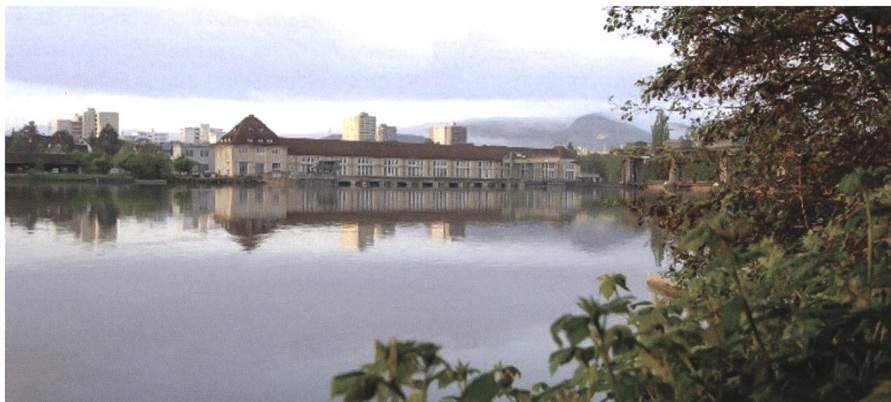
Kraftwerk Augst. Bild: AEW Energie AG.
