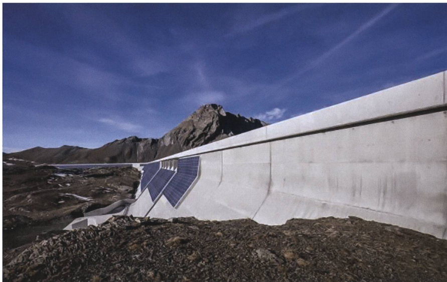
Axpo und IWB bauen an der Muttsee-Staumauer die grösste alpine Solaranlage der Schweiz. Bild: Axpo.
