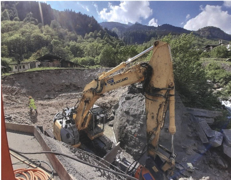
Bau Wasserkraftwerk Arvigo in Calanca. Bild: BKW.
