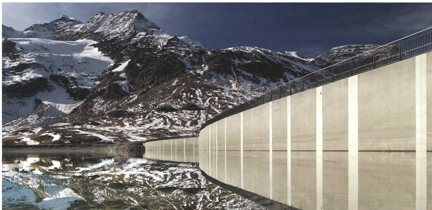
Für grosse Wasserkraftanlagen sollen gegenüber dem geltenden Recht die zur Verfügung gestellten Mittel verdoppelt werden. Bild: Staumauer Lago Bianco (Simon Walther).
