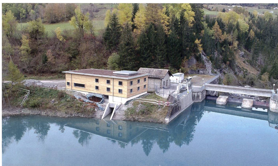
Wasserkraftwerk Adont. Bild: ewz
