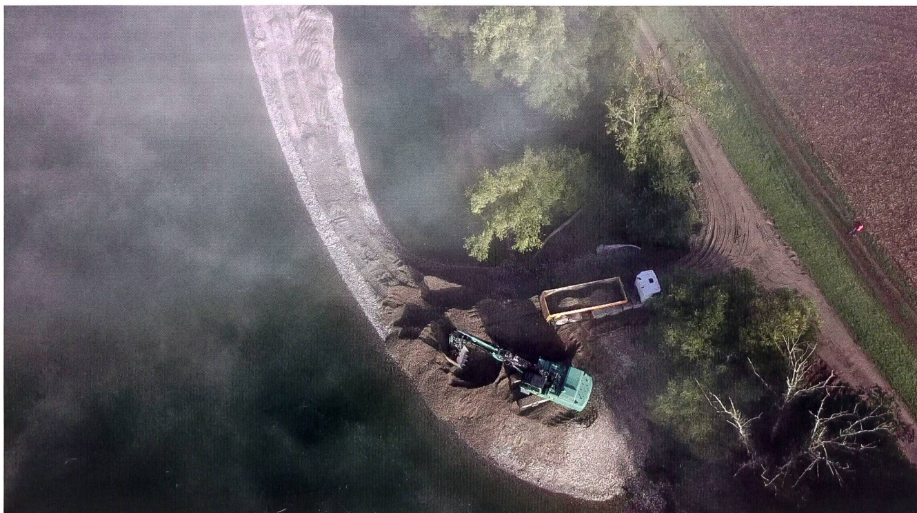
Eine mögliche Massnahme zur Sanierung des Geschiebehaushalts: Kiesentnahme oberhalb des Stauwehrs und Verlad auf LKW für die anschliessende Schüttung im Unterwasser. Kraftwerk Bremgarten-Zufikon an der Reuss. Foto: Carlos R. Wyss.
