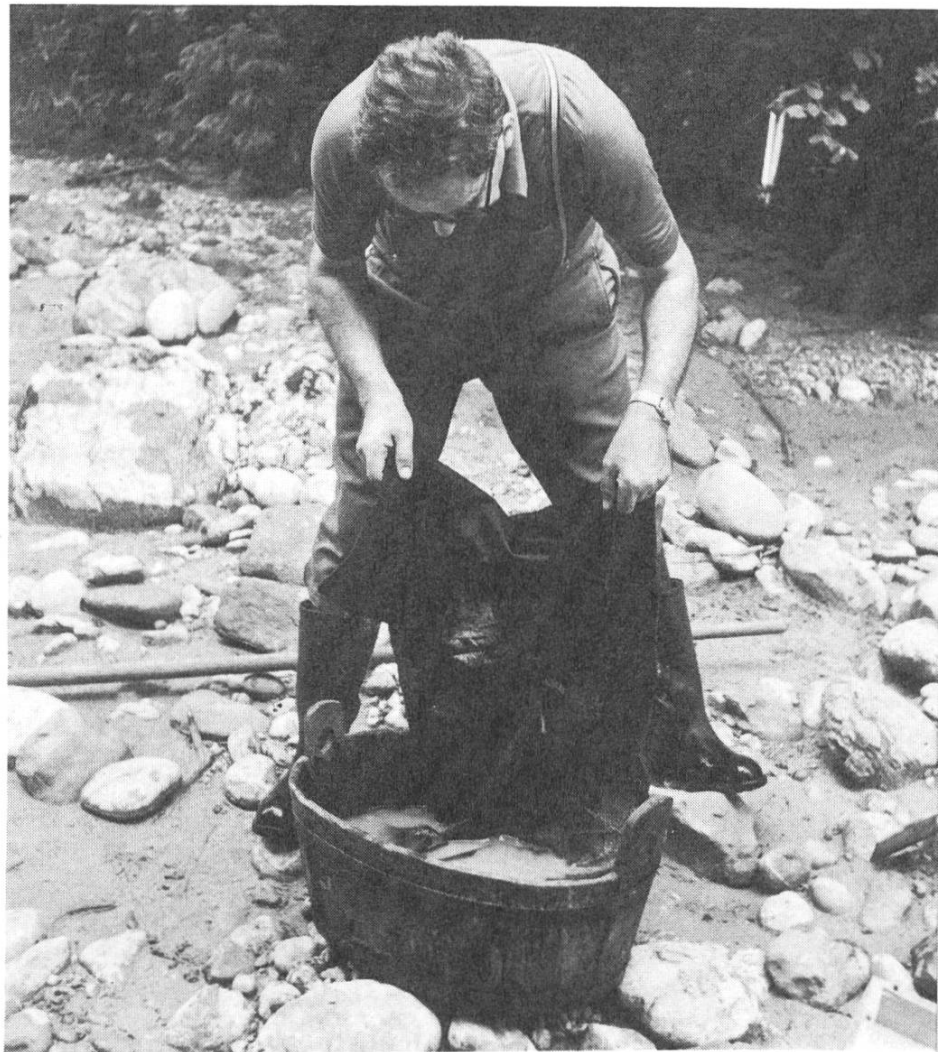
Goldgewinnung mit dem Waschstuhl. Diese Methode wurde seit Jahrhunderten bis Ende des letzten Jahrhunderts im Napfgebiet wie auch am Rhein angewandt.
