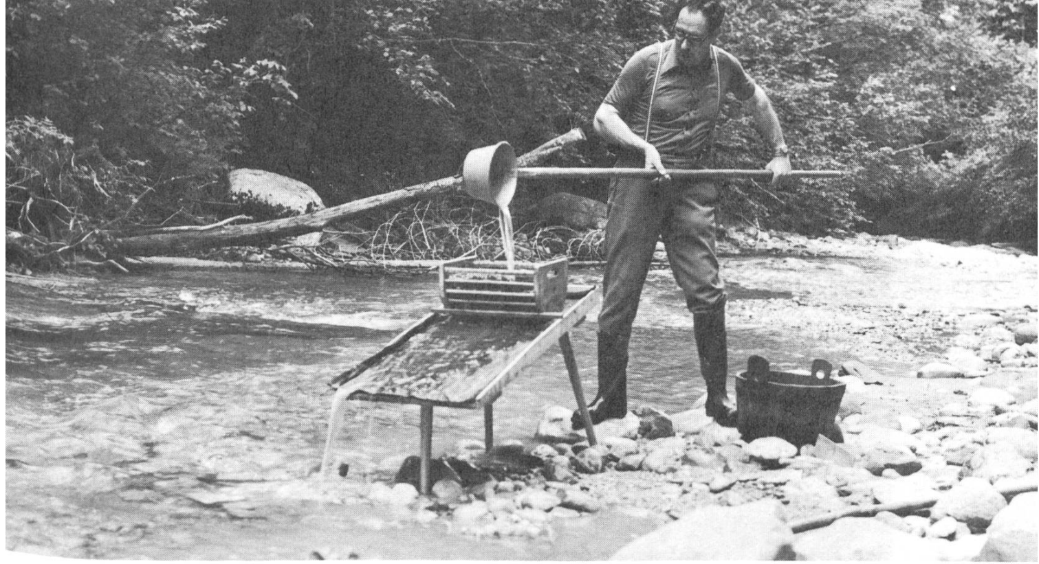
Goldgewinnung mit dem Waschstuhl. Diese Methode wurde seit Jahrhunderten bis Ende des letzten Jahrhunderts im Napfgebiet wie auch am Rhein angewandt.
