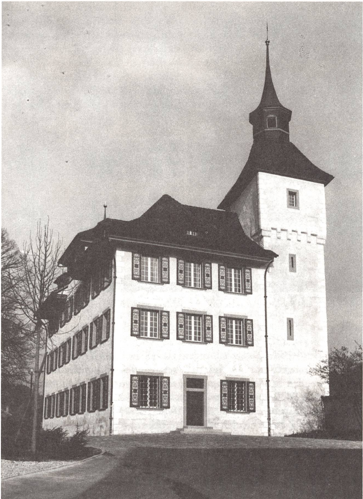
Das restaurierte Landvogteischloss Willisau. Erbaut 1690–1695 samt Befestigungsturm Ende 15./anfangs 16. Jahrhundert. Hauptzugang mit Vorplatz. Westfront.
