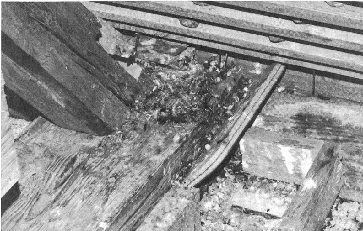
Nistplatz auf dem Dachboden, direkt über dem Einflugloch.
