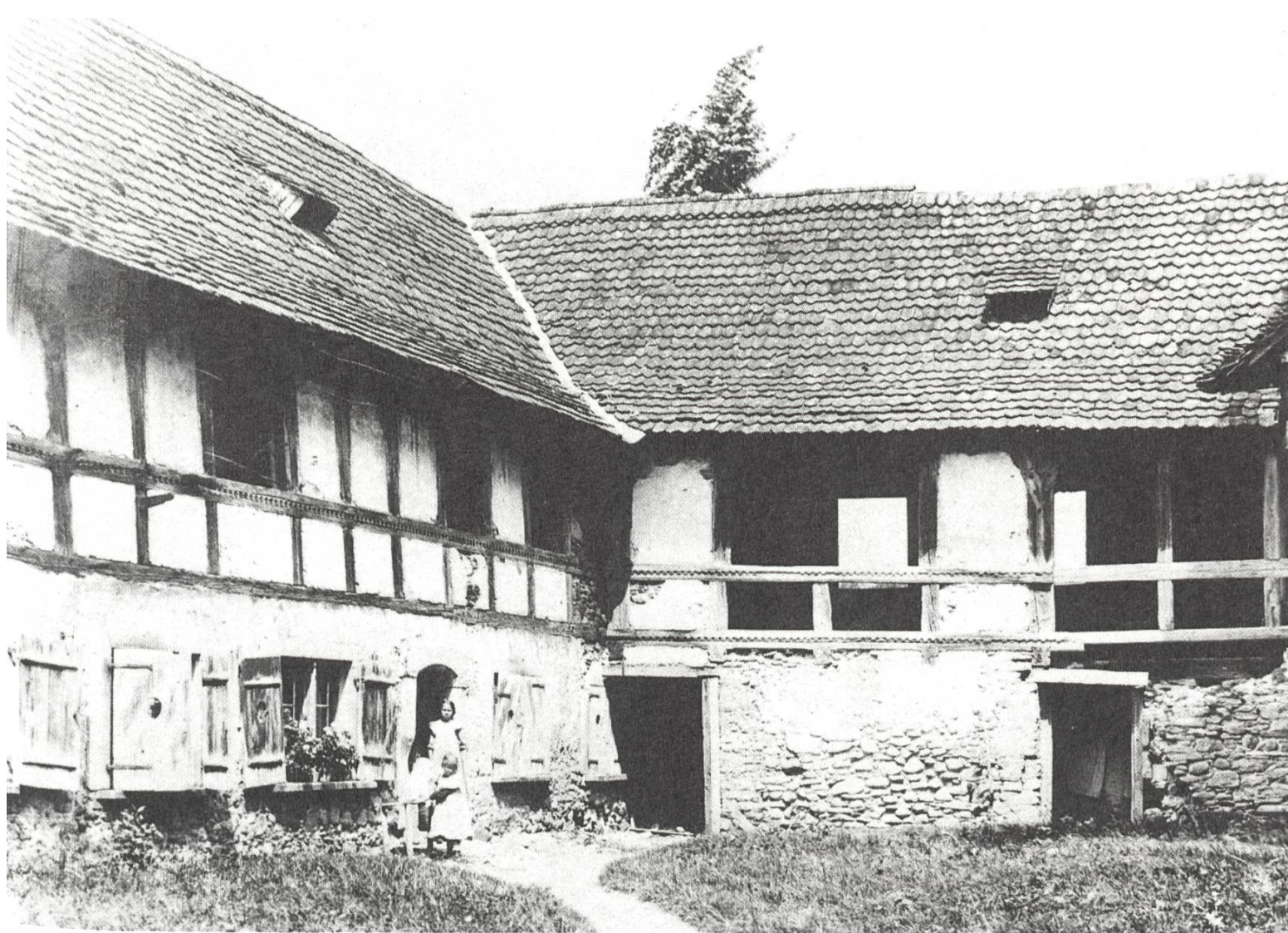
Teil des verwaehrlosten Klösterli (links) und Verbindungstrakt vor der Restauration. Im Erdgeschoss des «Klösterli» waren Küche, Dienstenstube und Vorratskammern untergebracht; im Obergeschoss lagen die Zimmer der Dienstboten.
