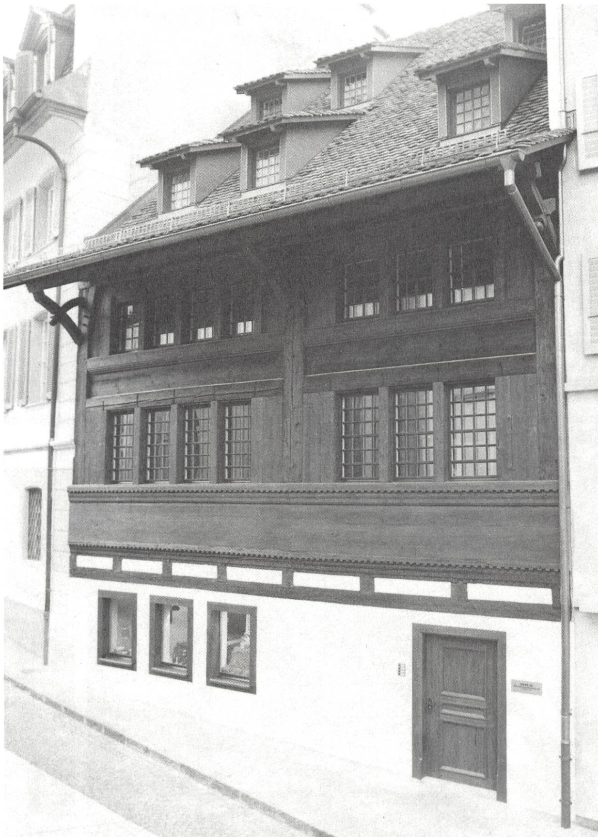
Haus Müligass 5, erbaut 1590, mit der bei der Restaurierung von 1982/83 freigelegten ursprünglichen Holzfassade.
