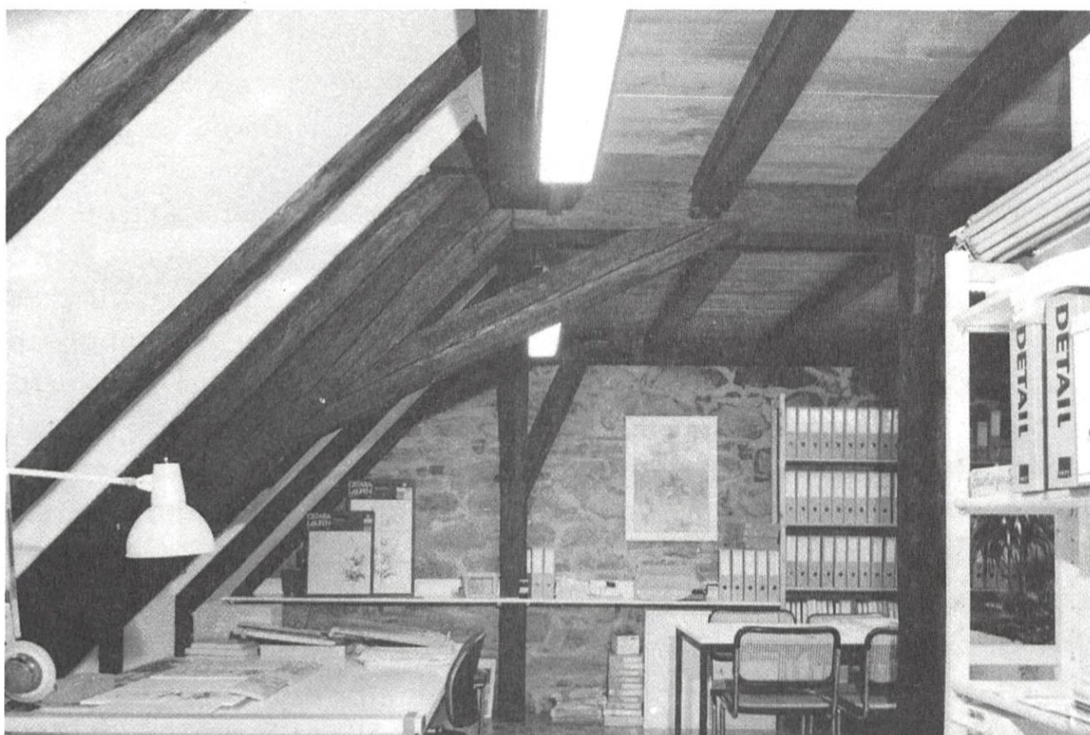
Bestehende 400 Jahre alte Dachkonstruktion im dritten Obergeschoss.
