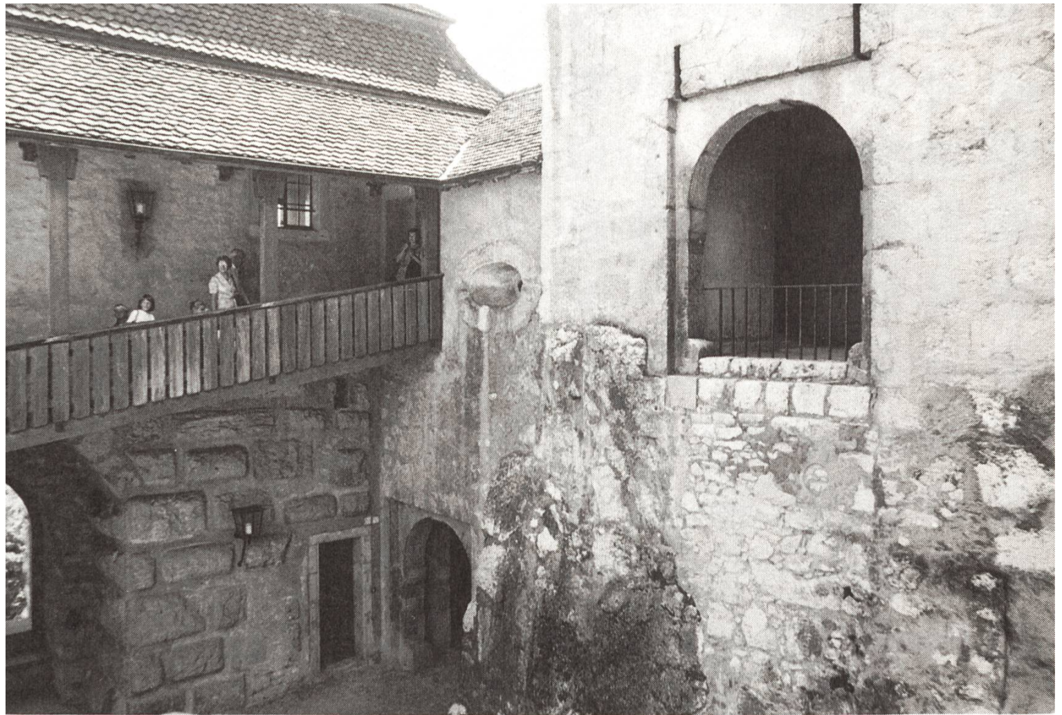
11 Eine Fallbrücke führte vom Schloss her über den ehemaligen Burggraben (dem heutigen Schlosshof) zum Paradeplatz; die Vertiefungen für die Schwungruten sind noch sichtbar. Das Gebäude links (mit moderner Stiege) enthielt oben eine offene Laube, darunter die Wachtstube (mit rechteckigem Eingang) zum ehemaligen Hauptportal (rechts daneben).
