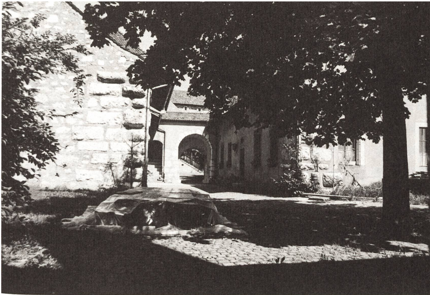
12 Blick auf Unteres Zeughaus (mit bossierten Eckquadern) links und Leutnantshaus rechts, dazwischen Durchgang zum Hohen Ravelin mit Hochwerk.
