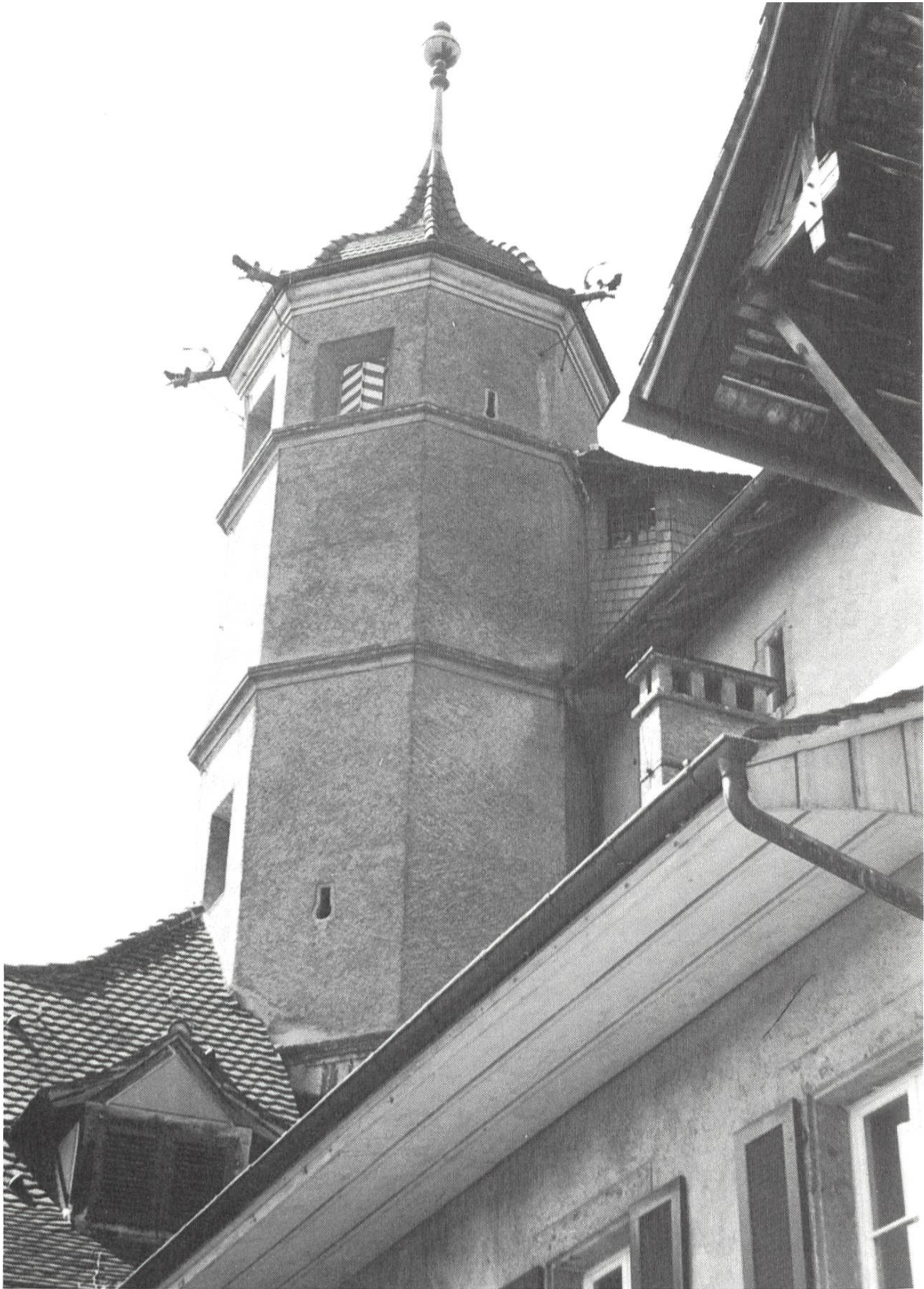
9 «Schneggen» (Treppenturm) von 1621/22 an der Südwestecke des mittelalterlichen Palas, dessen Stockwerke auf diese Weise besser zugänglich wurden.
