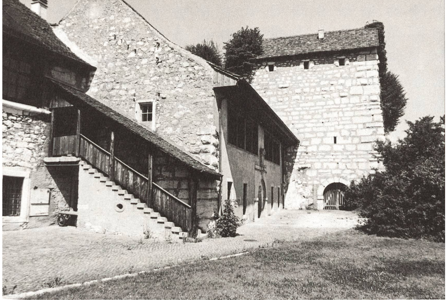
14 Bild vom Hohen Ravelin (dreieckige Schanze) auf das Obere Zeughaus (links) und das querstehende Hochwerk mit der Wachtstube (3 kleine Fenster).
