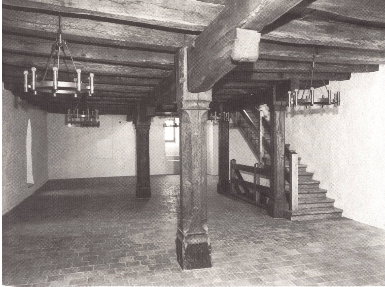
Die in alter Schönheit wieder hergestellte Kornschütte.
