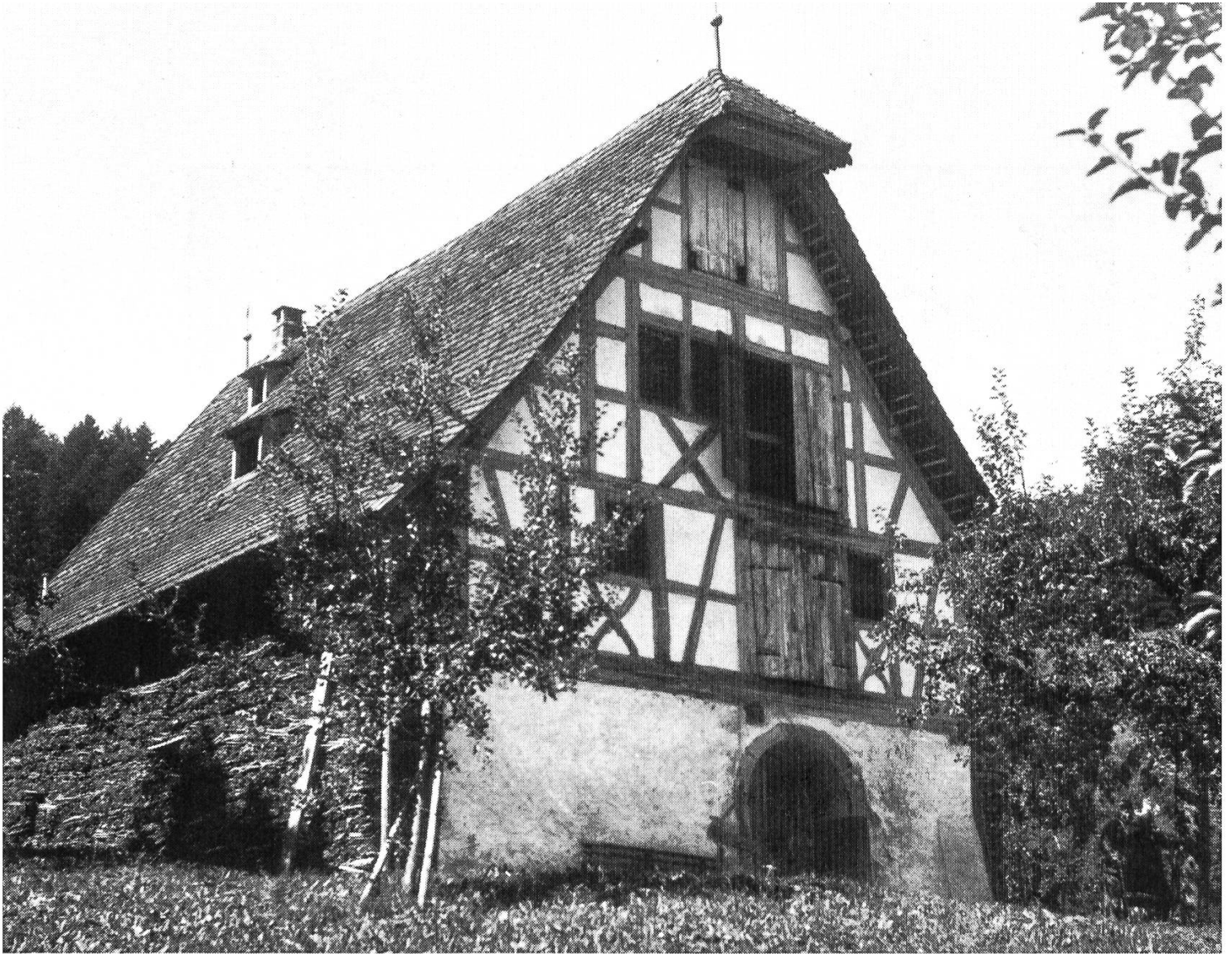
Die Kornschütte aus dem Jahre 1671 vor ihrer Restauration.
