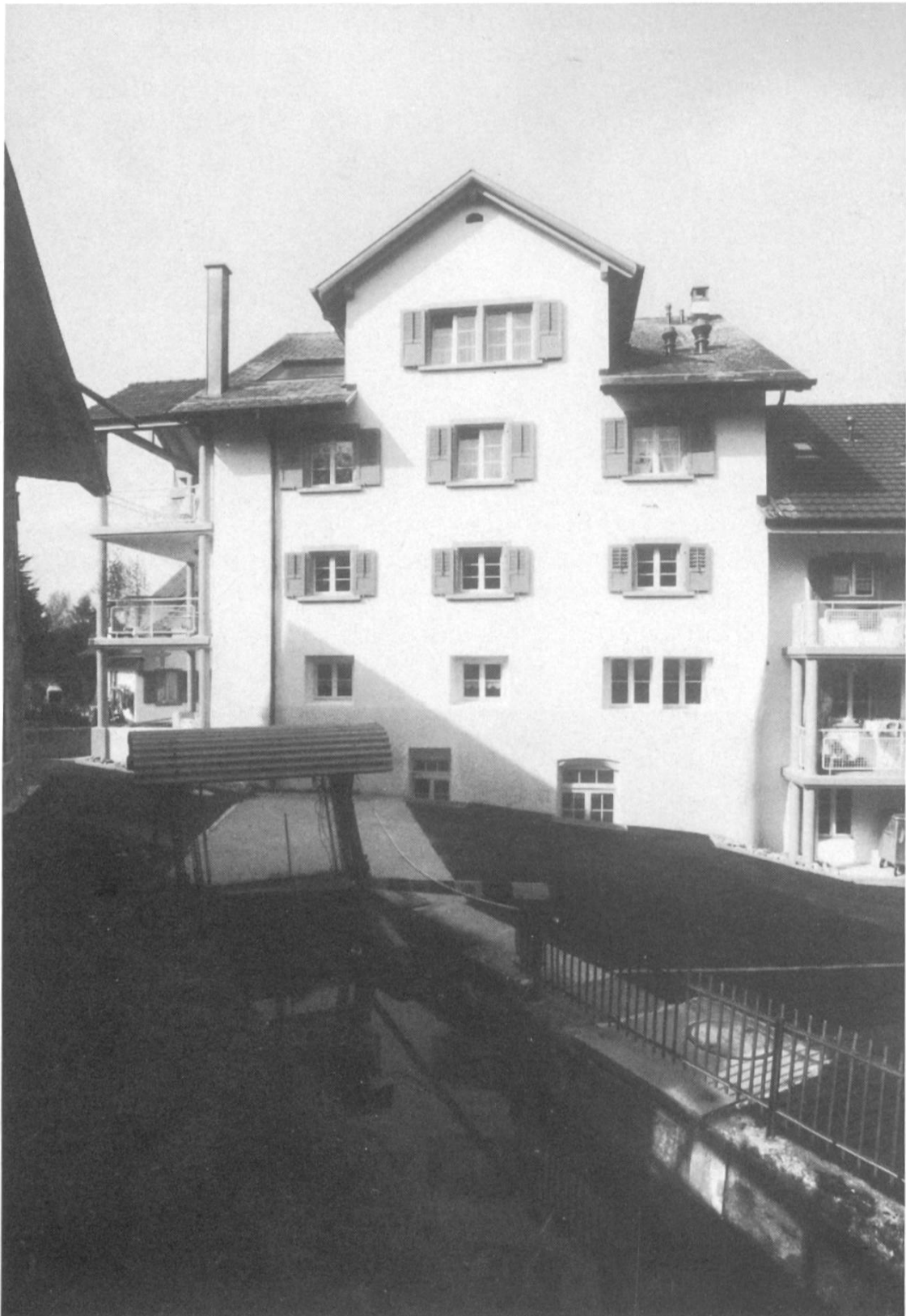
Dorfmühle mit Rechenanlage und Kanaleinlauf, Schötz.
