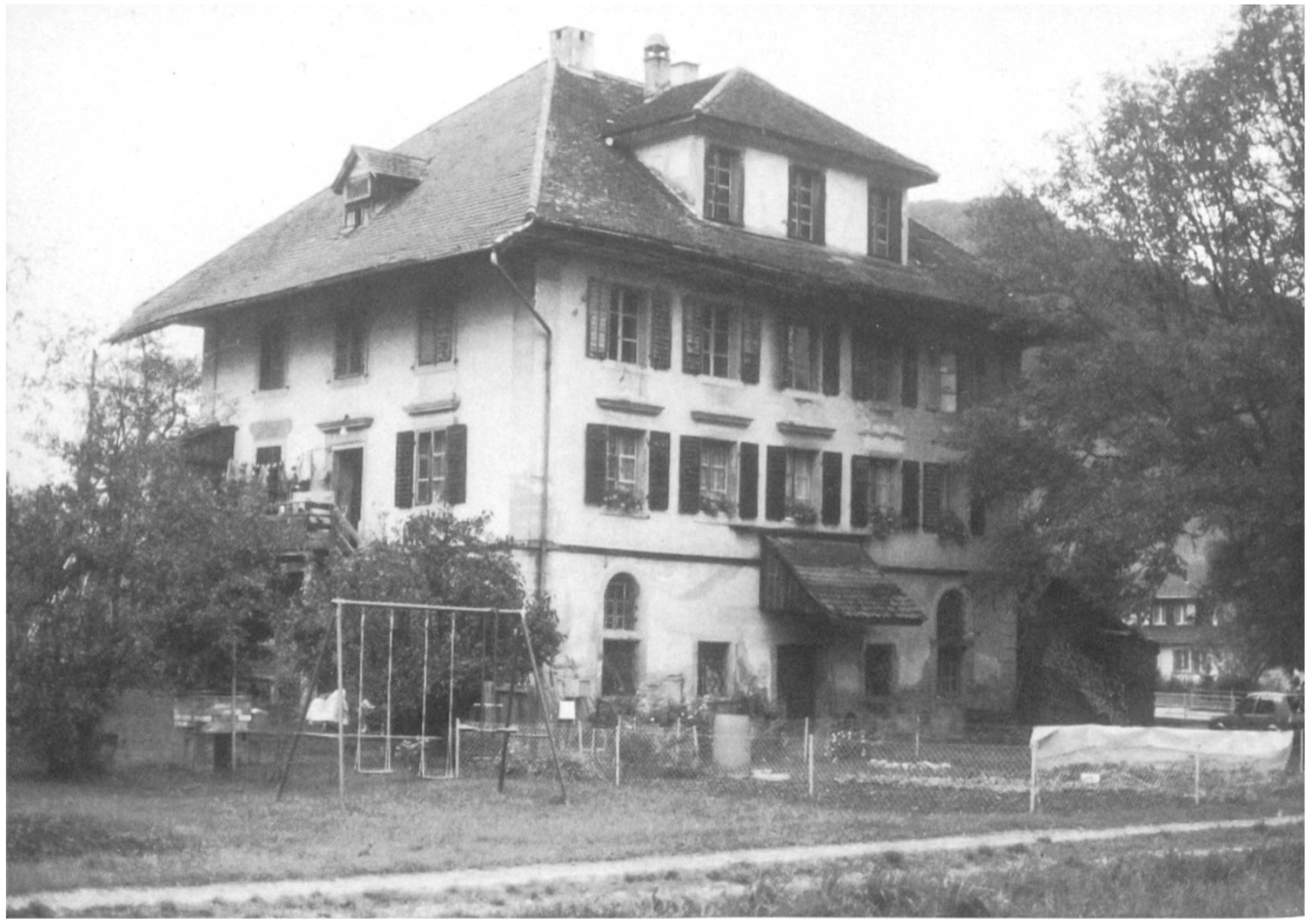
Ehemaliges Ziegeleikraftwerk, Burgrain, Sicht von SE.
