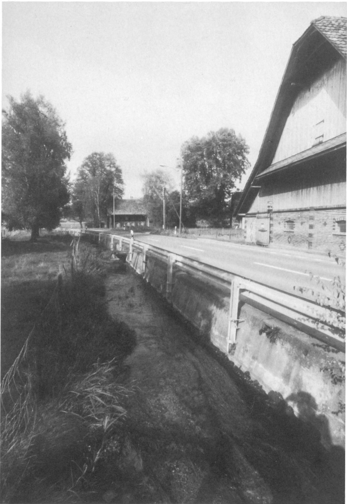
Oberwasserkanal der Dorfmühle Schötz in Alberswil.
