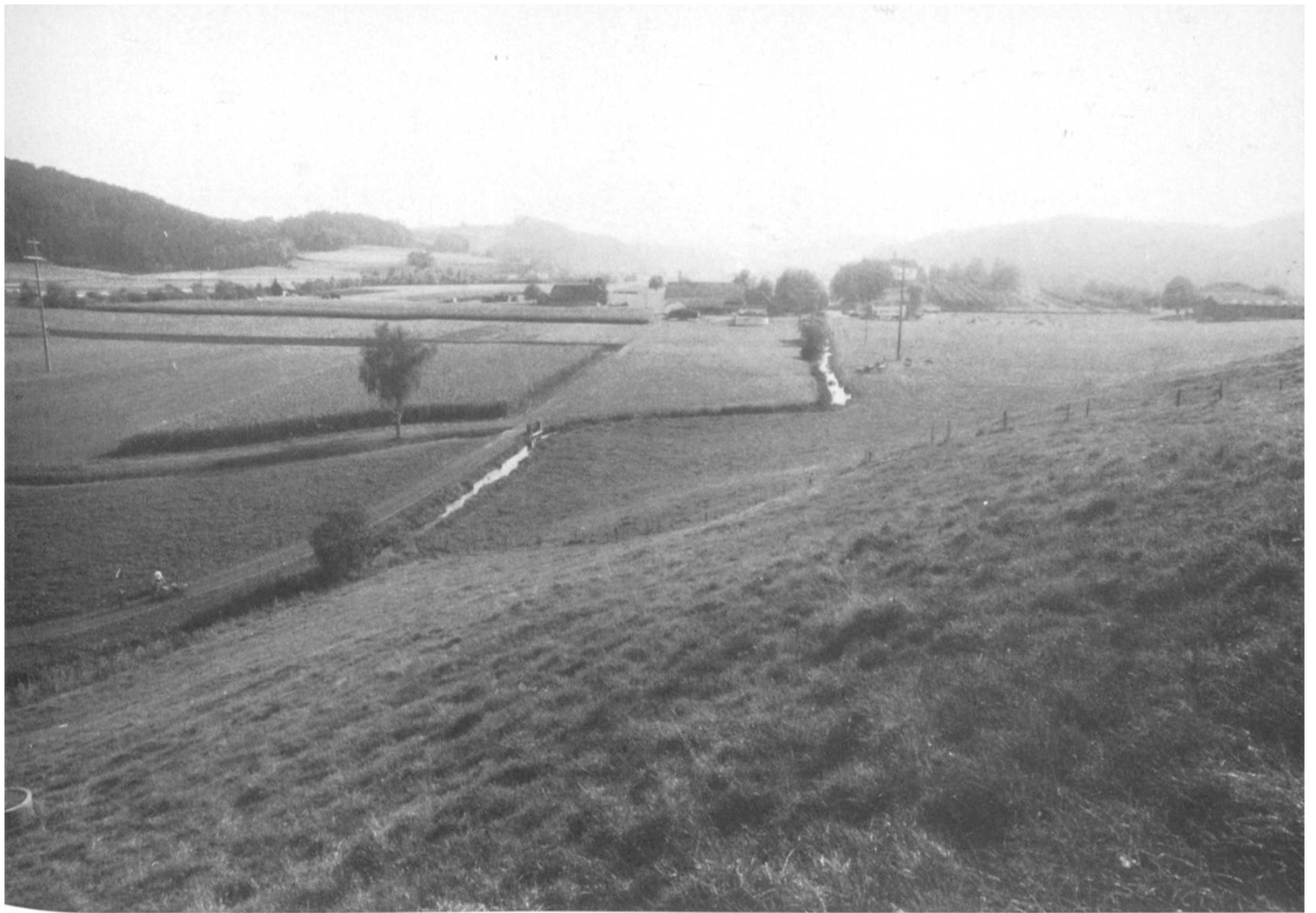
Unterwasserkanal und Anlage, Burgrain.
