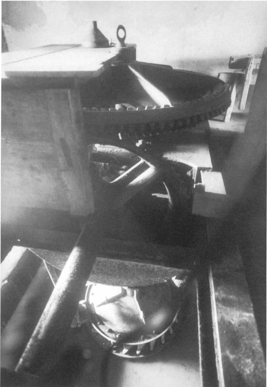
Turbine, Winkelgetriebe, Alberswil.
