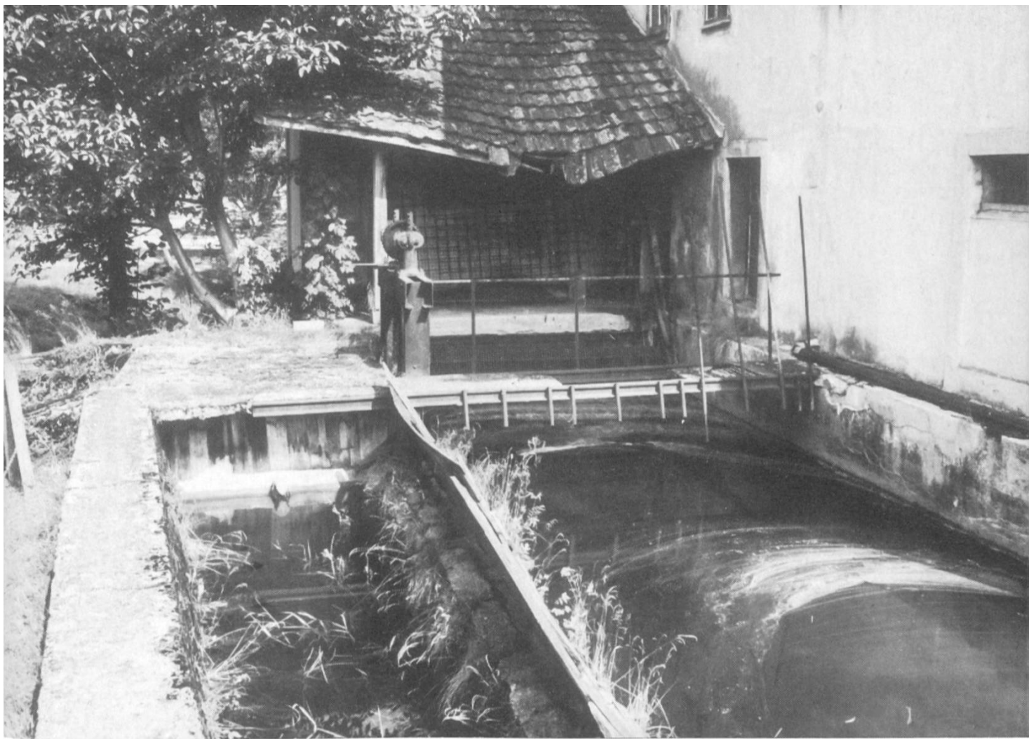
Oberwasserkanal und Turbinenbau, Burgrain.
