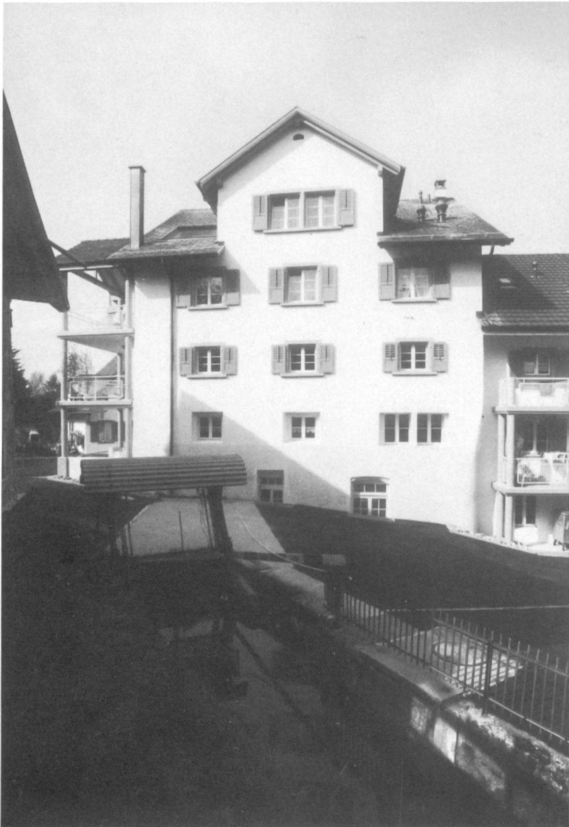
Dorfmühle mit Rechenanlage und Kanaleinlauf, Schötz.
