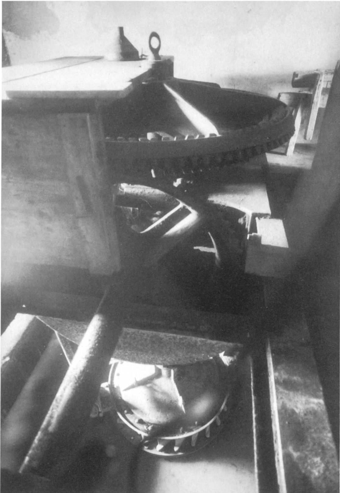
Turbine, Winkelgetriebe, Alberswil.
