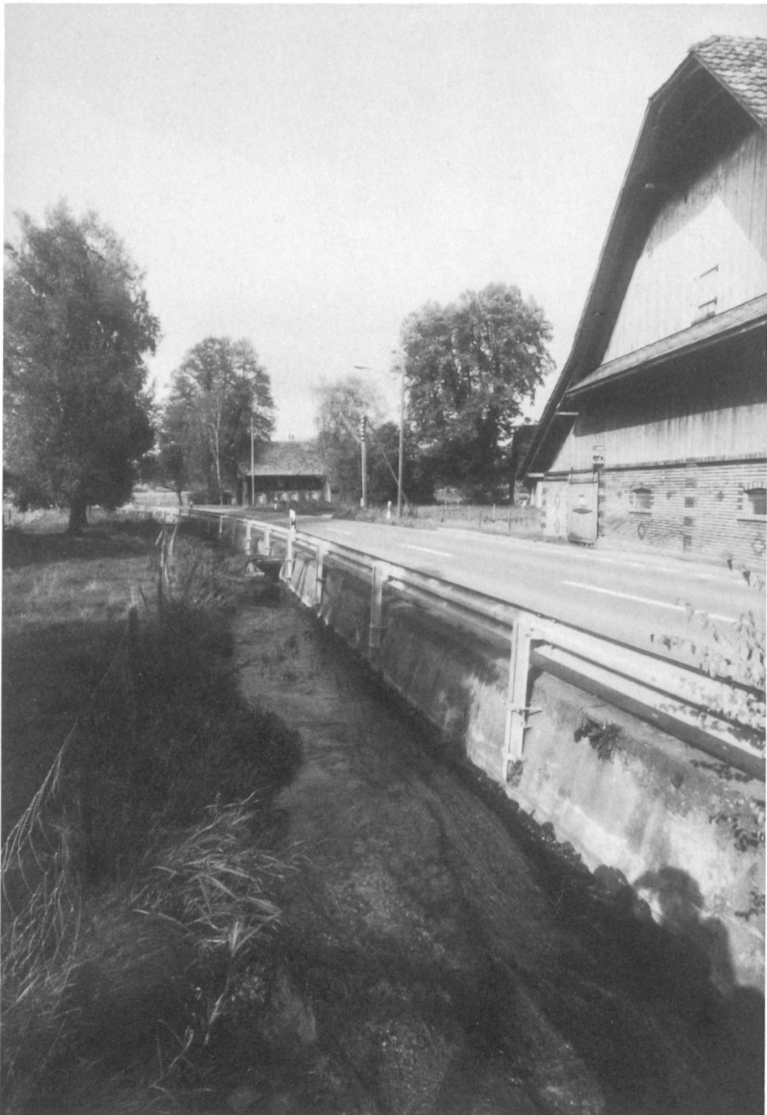
Oberwasserkanal der Dorfmühle Schötz in Alberswil.
