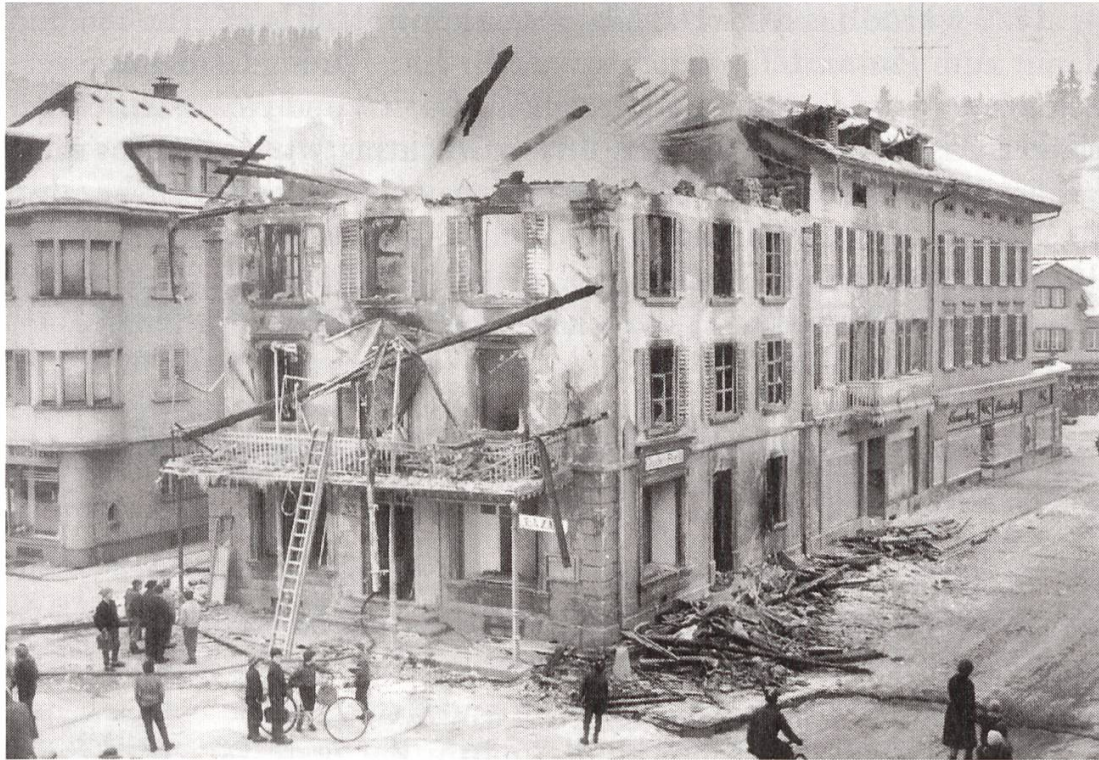
Das ehemalige Postgebäude am Postplatz, am Morgen nach dem verheerenden Brand bei minus 15 Grad Kälte, am 6. Februar 1963. Es wurde nicht mehr aufgebaut.
