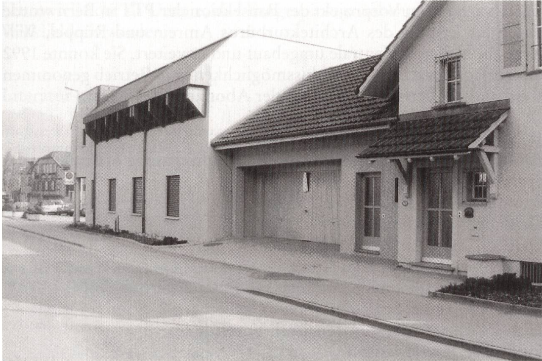
Die 1992 umgebaute und erweiterte Telefonzentrale.
